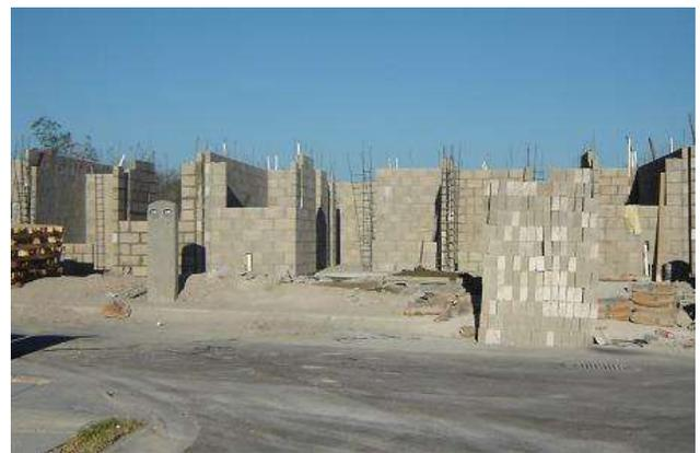
Imagen 18 y 19 Viviendas de interés social con molde para concreto y block de concreto.<sup>25</sup>
