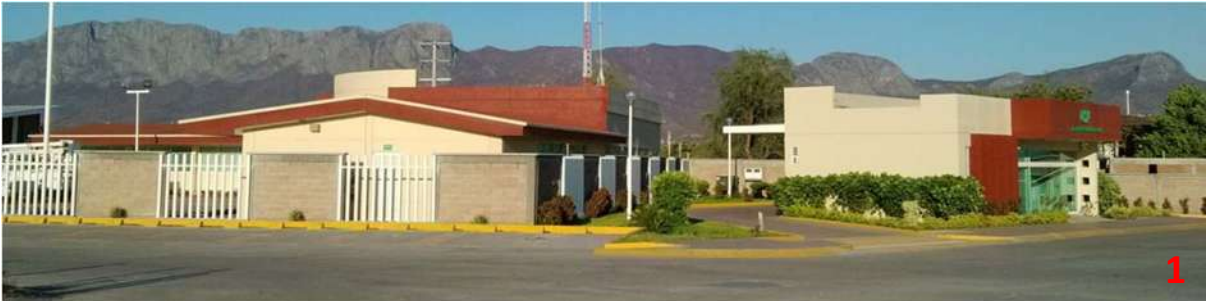
IMAGEN 75.- Oficinas centrales de la Comisión Federal de Electricidad en Huetamo. Por: NBL.
