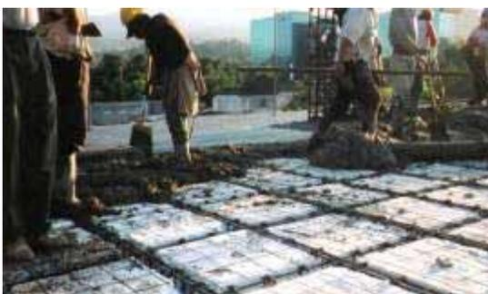
Imagen No. 96: Construcción de entrepiso de losa reticular de casetón de poliestireno.
