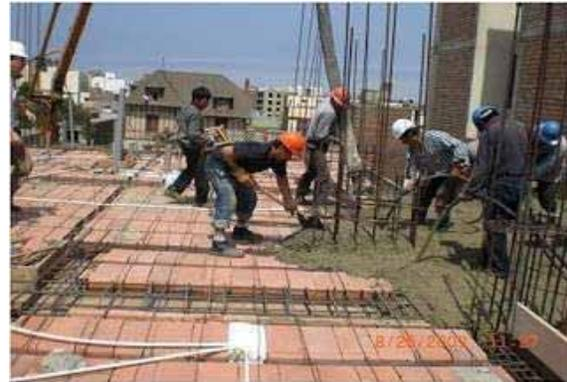
Imagen No. 98: vaciado de concreto para losa maciza
