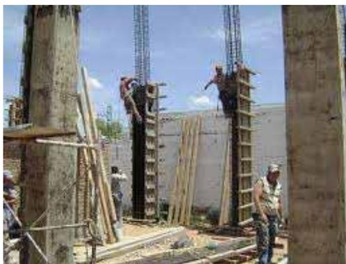
Imagen No 88: Columnas de concreto armado
