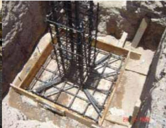
Imagen No. 87: Cimentación de zapata aislada de concreto armado.
