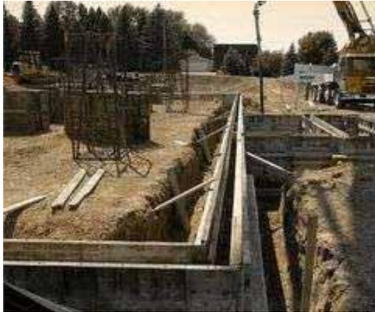
Imagen No. 86: Cimentación de zapata corrida de concreto armado.
