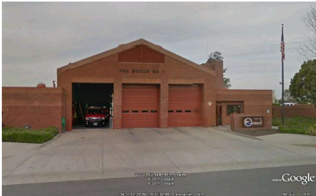
Imagen 6 , Estación de bomberos ubicada en Oxnard, California. Fuente: Google Earth.
