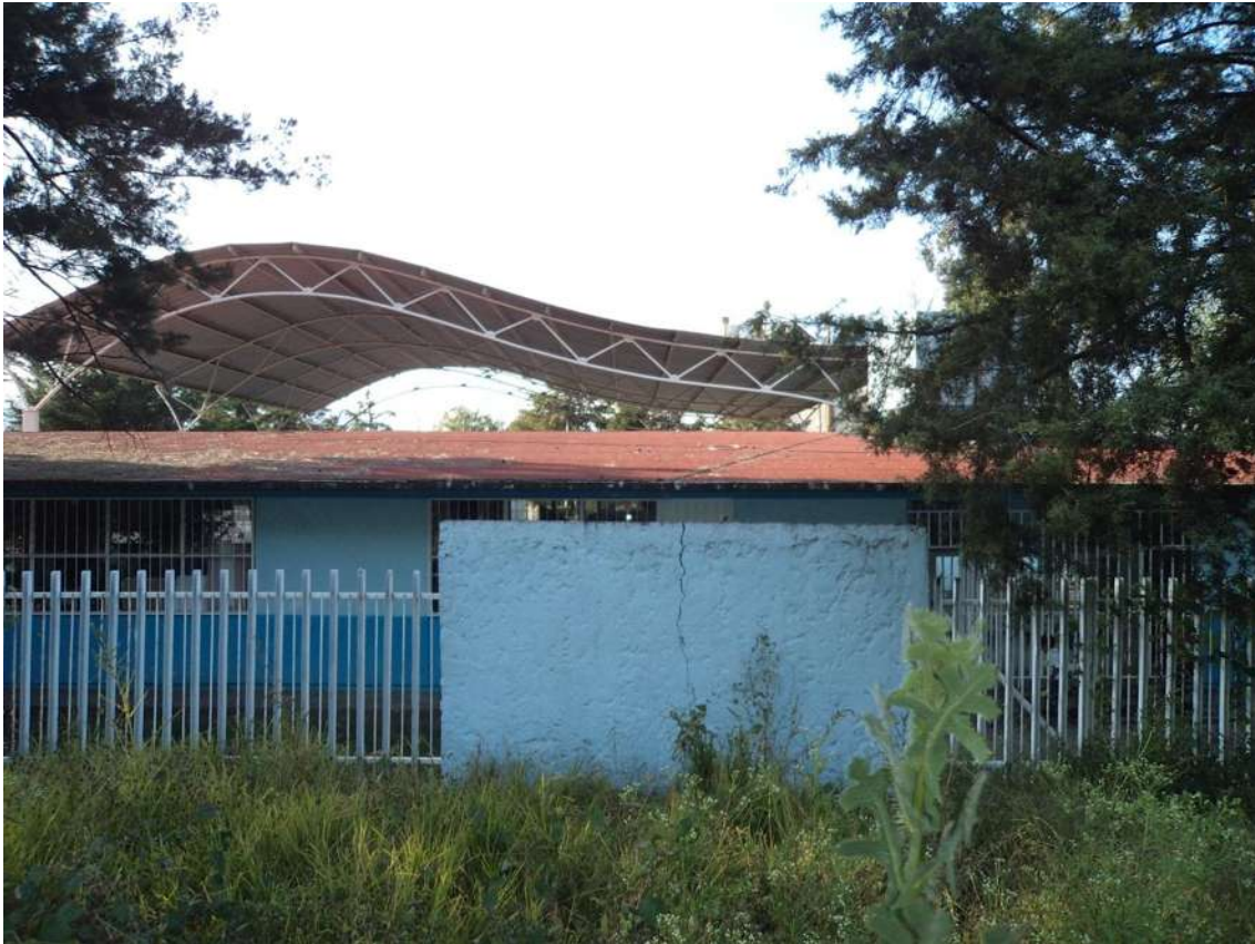
Imagen 24, Estructura de metal Fuente: C.V.A.
