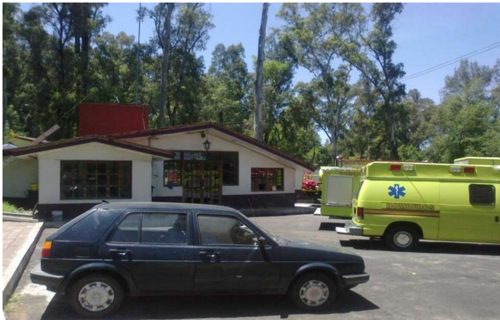
Imagen 16, Estación II de bomberos de Morelia, Michoacán, patio de maniobras y estacionamiento, Autor : C.V.A.
