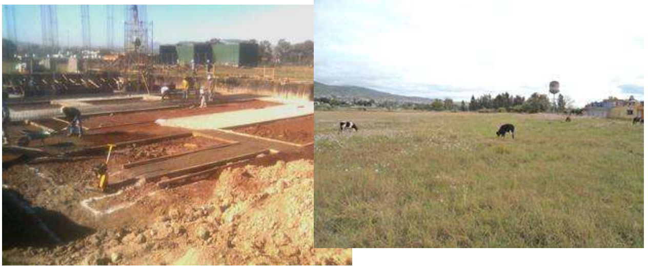
Imagen 26 y 27 , Utilización de zapatas corridas y foto del terreno, Autor: C.V.A.
