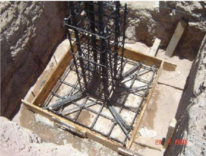
Ilustración 20 Zapata aislada Fuente: en línea: <http://www.iiarquitectos.com/2010/01/proceso-constructivo-de-una-zapata.html> Consultada 07 Mayo 2012
