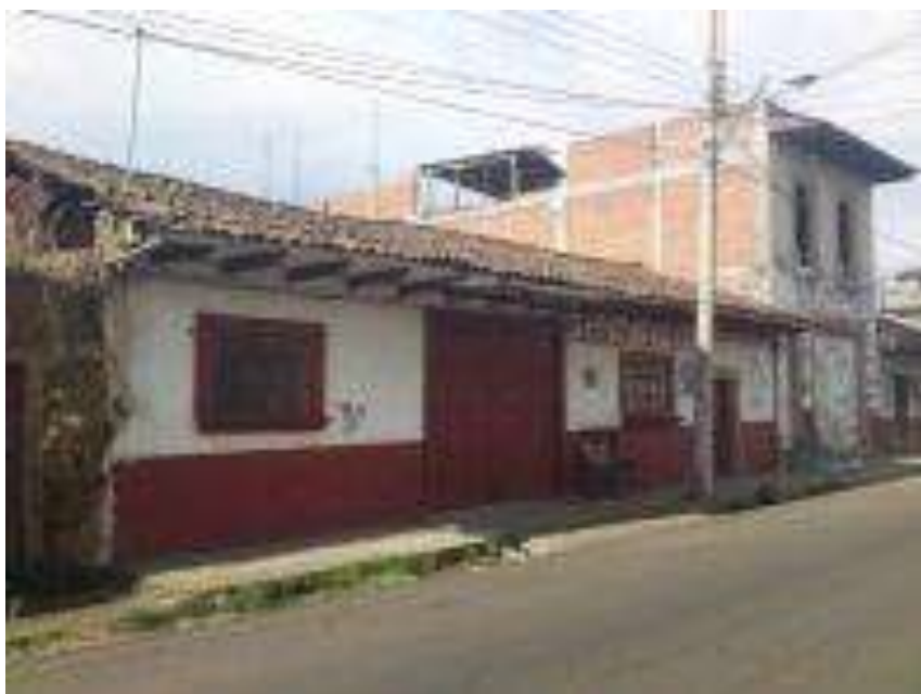
Fig. 1.4 Casa habitación adaptada a uso de Casa de Cultura para Santa Clara del Cobre. Actualmente sin uso. Fuente: Sara Janette Cázares Reyes.
