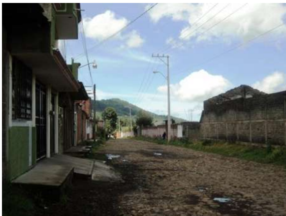
Fig. 1.71 Postes de Energía Eléctrica y Alumbrado Público Fuente: Sara Janette Cázares Reyes
