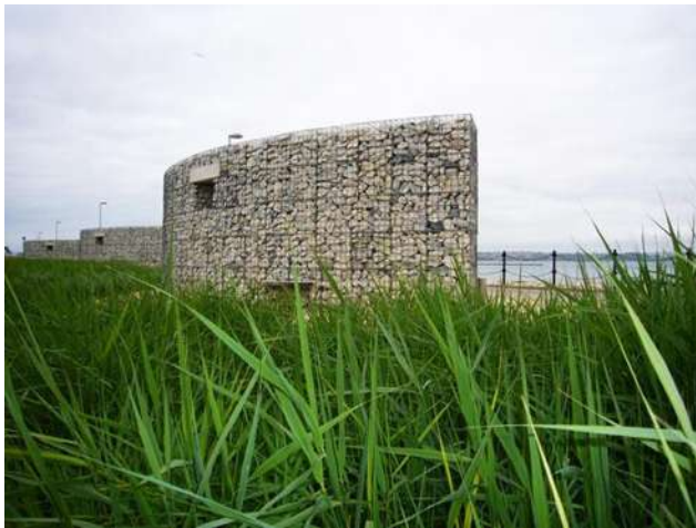
Fig. 1.109 Uso de Muros Gabion como muros divisorios en una plaza pública. Portland, Dorset, U.K. 32
