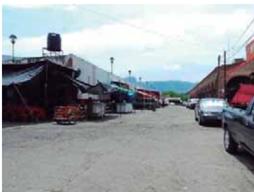
Imagen 10. Fachada posterior de la central de autobuses foraneos.
