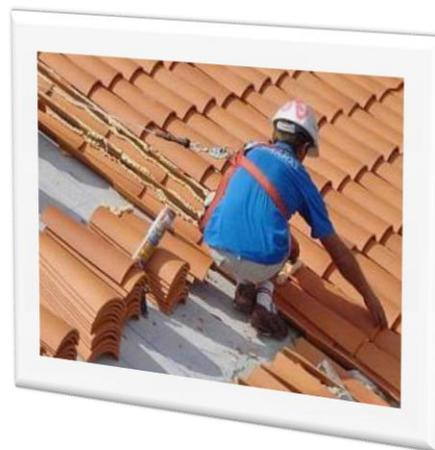
**Imagen 29** Colocación de teja. Fuente: <http://iztapalapa.olx.com.mx/teja-de-barro-natural-calidad-de-exportacion-iiid-278912697>
