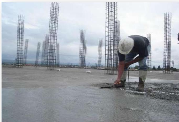
**Imagen 34** Losa maciza colada. Fuente: <http://www.aguascalientes.gob.mx/transparencia/calidad/sop/obras/ReportesVarios/fotostrasp.asp?StrIdContrato=4617>
