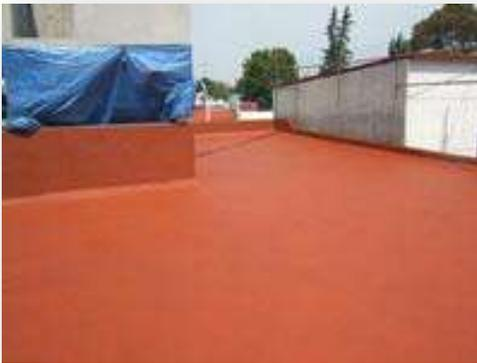
**Imagen 31** Losa impermeabilizada. Fuente: <http://www.reciclandollantas.com.mx/servs.htm>
