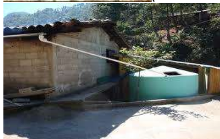
Imagen de cisterna de ferrocemento utilizada en la colonia ecológica de La Mintzita, sistema de captación de agua pluvial.
