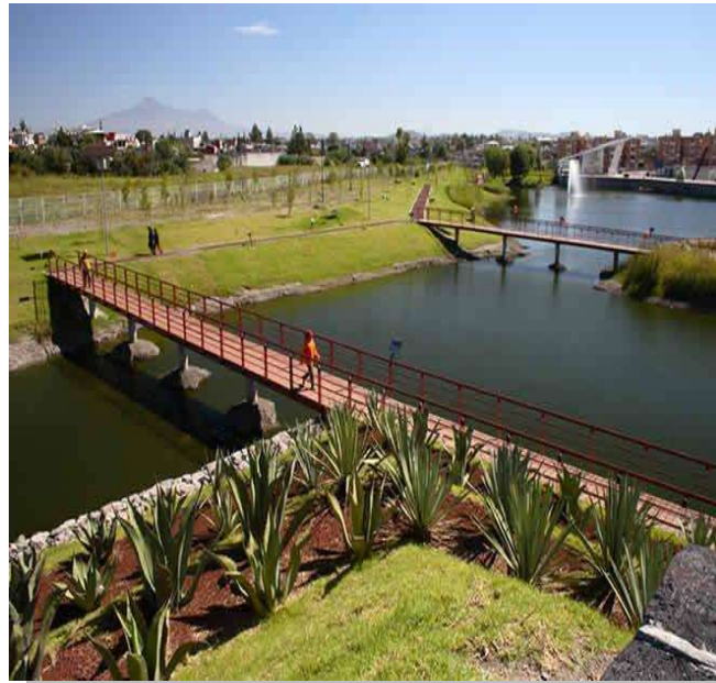
Imagen 2: Toma del puente que atraviesa la laguna Imagen. Fuente: Arquine, Espacio público, espacio activado , CITEM, México, 2012. p. 52
