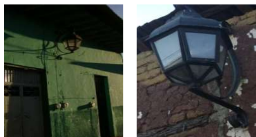
FIG. 70. Arbotantes con forma de faro tipo colonial, luminaria existente alrededor de las calles de centro histórico.
