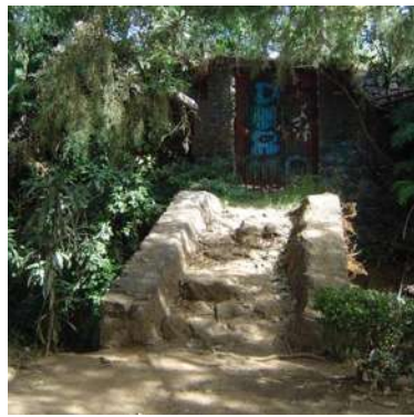
FIG.91. Puente peatonal existente en la zona de la camelina, el cual se tomara su tipología para la construcción de los puentes peatonales.
