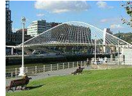
FIG. 33. Zubizuri, puente peatonal del campo del volantín.
