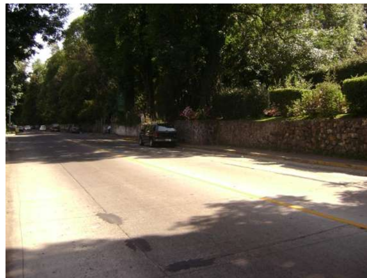
FIG.88. Avenida Fray Juan de San Miguel, vista Norte a Sur de doble circulación y un carril para estacionamiento.
