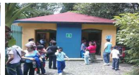
FIG.53. Baños en el segundo acceso al parque Nacional.
