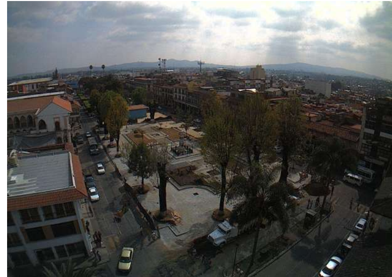
Imagen 43. Plaza en el centro histórico de Uruapan, recientemente remodelada.
