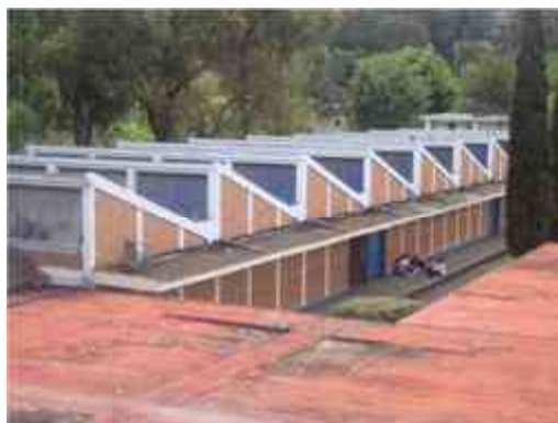
Imagen 6.16. Ejemplo de la cubierta tipo diente de sierra revisada en la ciudad de Morelia en la escuela secundaria técnica 3. Fotografía tomada el 19-02-2010.
