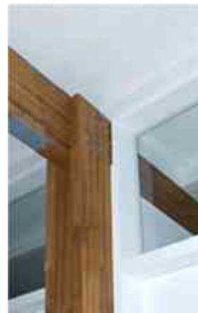
Imagen 5.45. Combinación de elementos estructurales, fotografía tomada de la página http://www.archdaily.mx/62219 el 23-10-2012.
