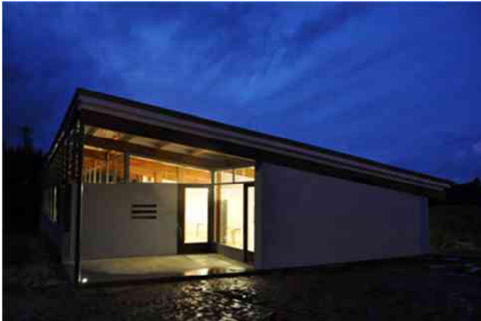
Imagen 5.43. Combinación de elementos estructurales, fotografía tomada de la página http://www.archdaily.mx/62219 el 23-10-2012.
