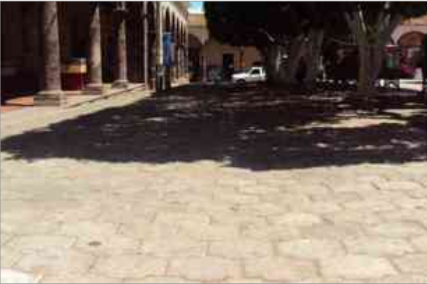
Liberación de la superficie de adocreto en el perímetro de la plaza. El adocreto es un material cuya superficie es incomoda al transito de los peatones por lo cual se reintegrara con losetas de cantera rectificadas colocadas a hueso
