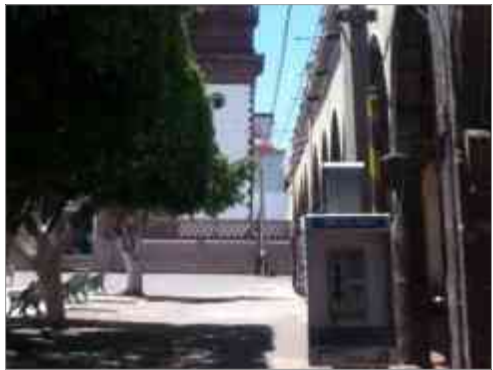
Desmontaje y retiro de caseta telefonica
