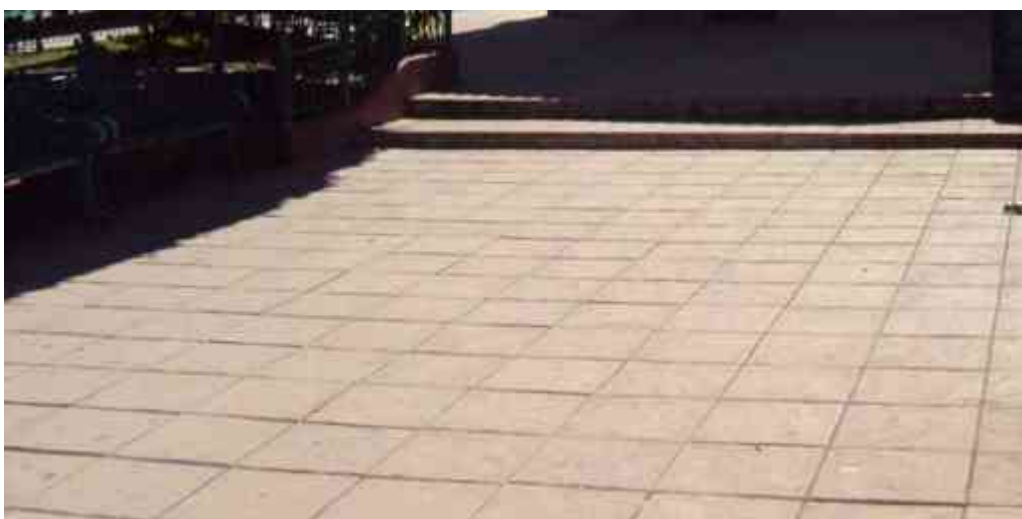
Ilustración 23. Concreto Estampado. (Fotografía: Francisco Mtz.)
