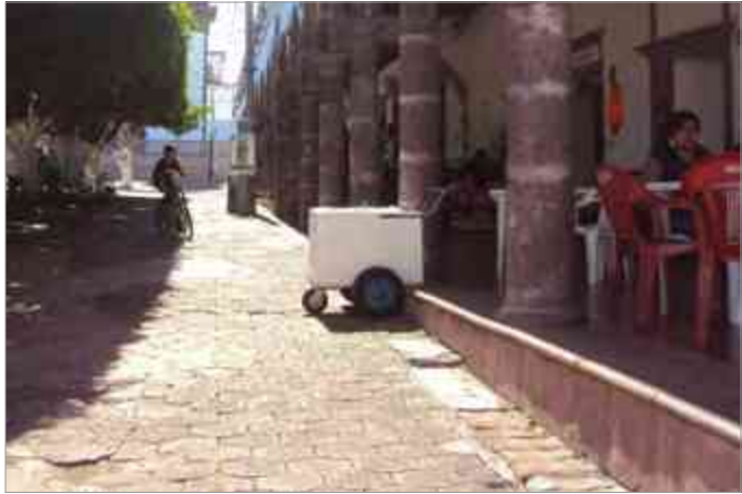
Consolidación de elementos de cantera y adocreto tipo cruz romana. Unificación del nivel de piso terminado con pendiente hacia drenaje pluvial
