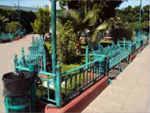
Reubicación de cestos de basura colocados en jardineras. Liberación de arriate de jardinera y desmontaje de barandal de herrería
