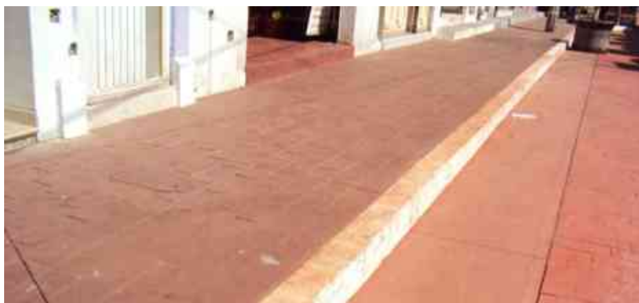
Ilustración 31. Calle Francisco I. Madero (Banquetas, guarniciones y pavimento) (Fotografía: Francisco Mtz.)
