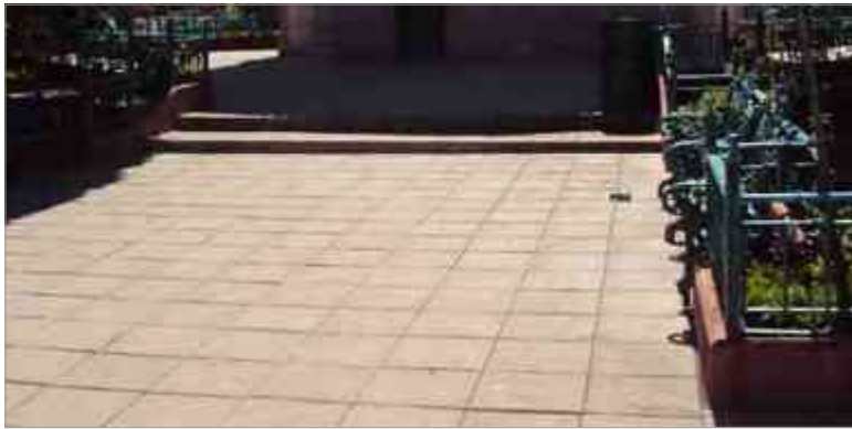
Retiro de concreto simple estampado ya que es un material que resulta inapropiado al contexto y por su poca permeabilidad
