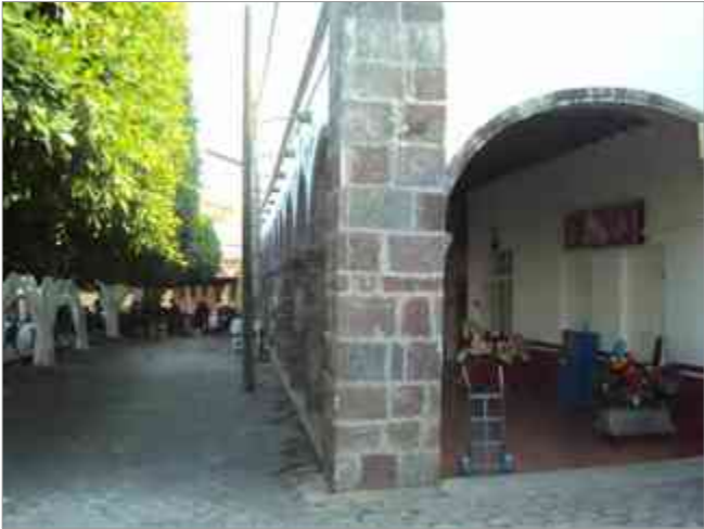
Lineracion de poste de madera de CFE Liberacion de cableado aereo.
