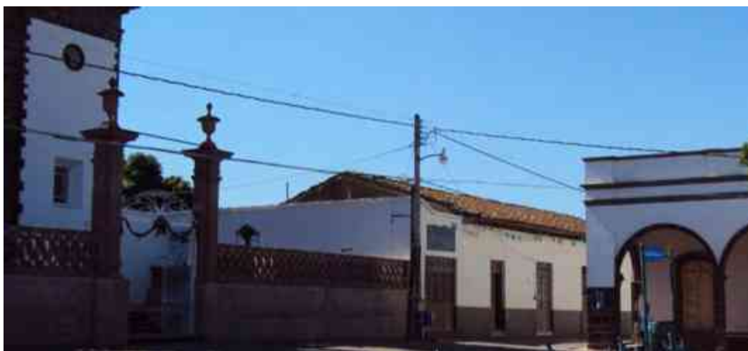
Ilustración 26. Canalización de línea eléctrica. (Fotografía: Francisco Mtz.)
