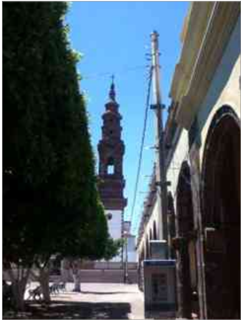
Lineracion de cableado aereo y postes de CFE
