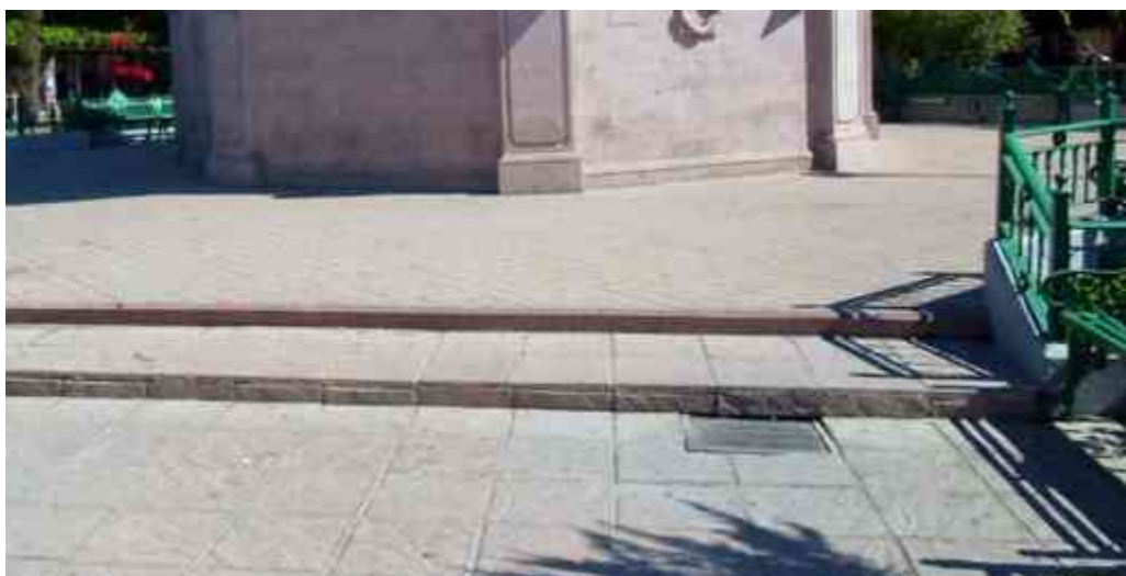
Ilustración 24. Coladera de agua pluvial. (Fotografía: Francisco Mtz.)
