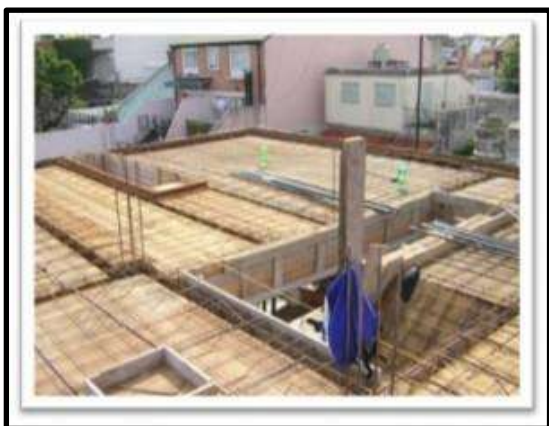
Fig. 48. Cimbrado de Losa Maciza, Casa Habitación, Mondragón Olvera Patricia, Ciudad Hidalgo Michoacán, 2013
