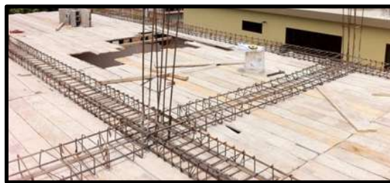
Fig. 49. Armado de una losa, Mondragón Olvera Patricia, Ciudad Hidalgo Michoacán, 2012
