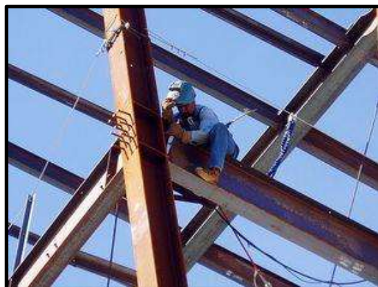
Fig.51. Estructura metálica, Cinopolis, Mondragón Olvera Patricia, Ciudad Hidalgo Michoacán, 2012
