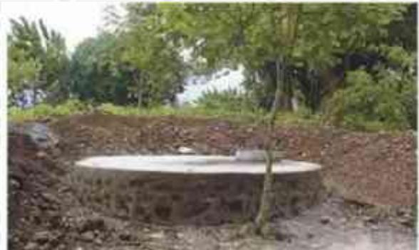
Fig. 43.- Cisterna de ferrocemento.
