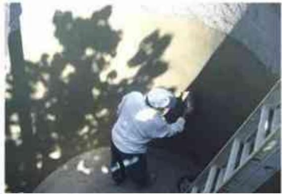
Fig. 42.- Engarrado y pulido de la pared de cisterna para almacenamiento de aguas pluviales.
