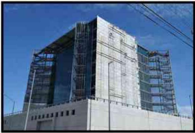
**Imagen 777** Aplicación de Tablamiento con su estructura metálica
