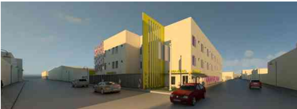
IMAGEN 12. CONFORT TERMICO VISTA DE FACHADA (USO DEL POLICARBONATO CELUAR COMO REGULAR TERMICO Y AISLANTE)
