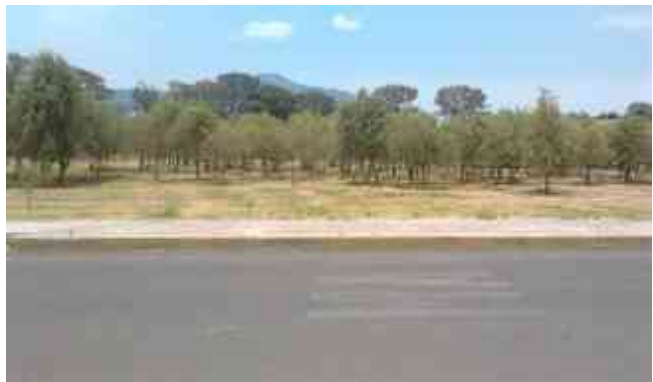
Ilustración 34. Pavimentación y banquetas existentes.
