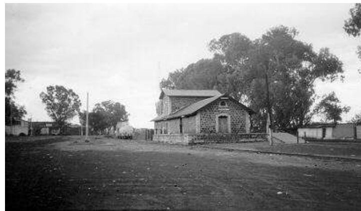
FOTO 01, Vista de la Estación de ferrocarril. J.A.R.O.
