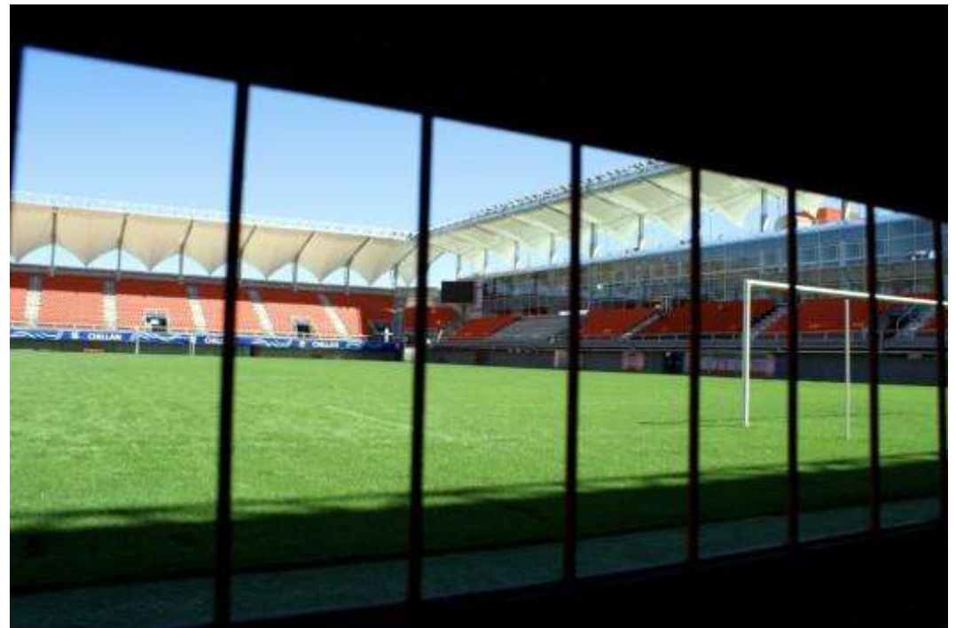
FOTO 29, VISTA DE PALCOS. www.archdaily.mx 19/0/2012
