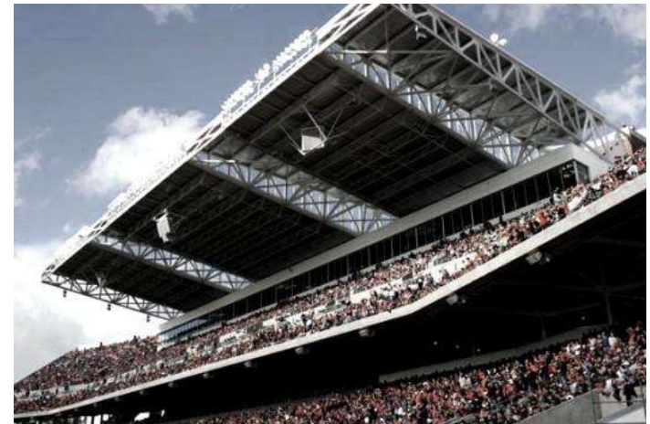
FOTO 65, ESTRUCTURA METALICA EN CUBIERTA. www.googleimágenes.com . 07/10/2012
