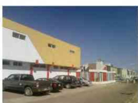
Fig.1.2.2.2. Fachada lateral y estacionamiento
