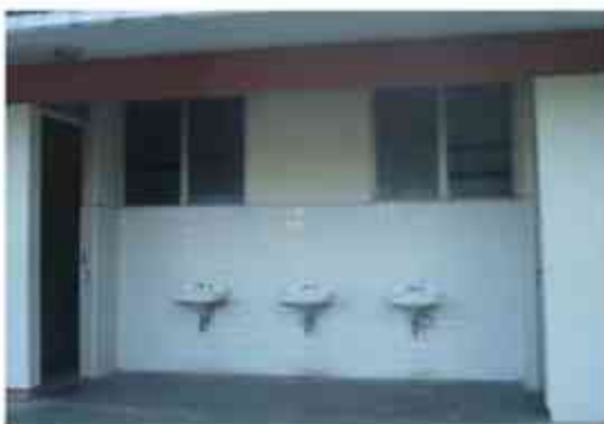
Fig. 1.2.1.12. Sanitarios y lavamanos vista exterior para el aseo de los niños y personal que labora en la institución
