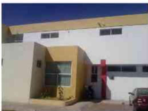
Fig.1.2.2.2. Fachada lateral y estacionamiento vista lateral
