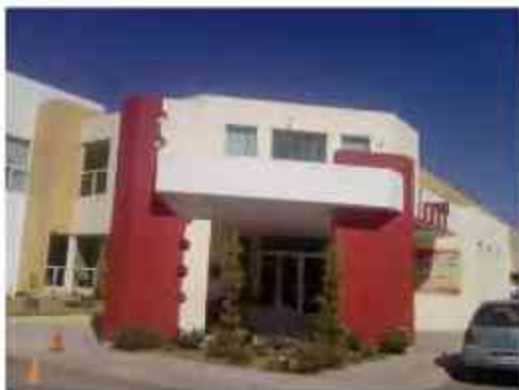
Fig. 1.2.2.1 Acceso vista lateral
