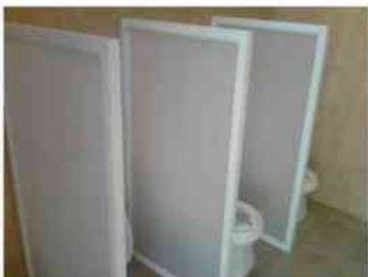
Fig. 1.2.2.26. Baños de H y M
