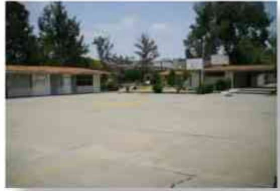
Fig. 1.2.1.15. Patio central que funge como vestíbulo principal
