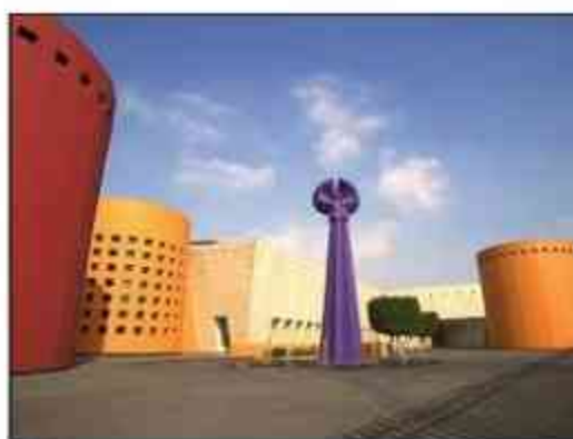
Fig. 1.2.3.1.2. CRIT estado de México
