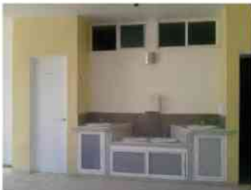
Fig. 1.2.2.21. Baños de H. Y M
