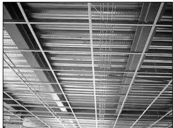
Imagen 63. Colocación de los soportes para falso plafón
