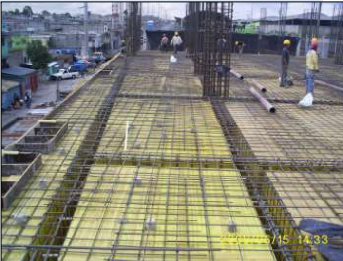
Imagen 58. Armado de una losa plana de concreto reforzado
