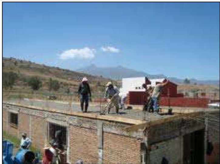
Imagen 59. Terminación de losa de concreto armado
