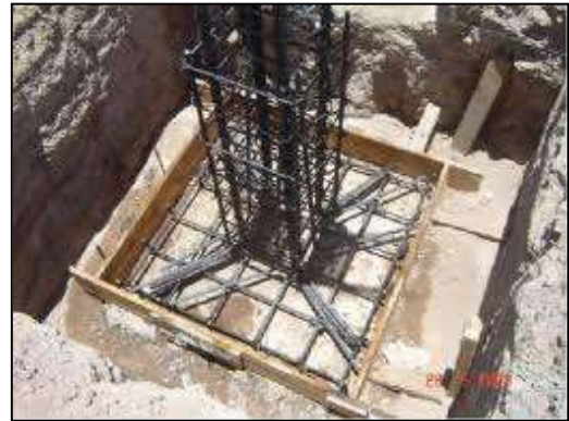
Imagen 54. Cimbrado de zapata aislada
