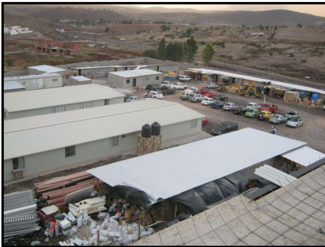
Figura 047. Imagen de Casetas para Personal Técnico Dentro de la Obra. Fuente: Víctor Hugo Servín Fuentes. [2012]
