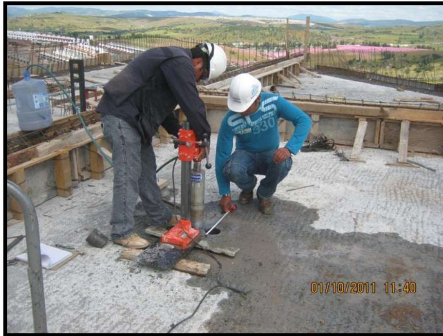
Figura 052. Imagen de Pruebas de Laboratorio, Extracción de Corazones de Concreto en Azotea del Módulo de Consulta Externa. Fuente: Consultores de la Obra Publica S. C. [2011]
