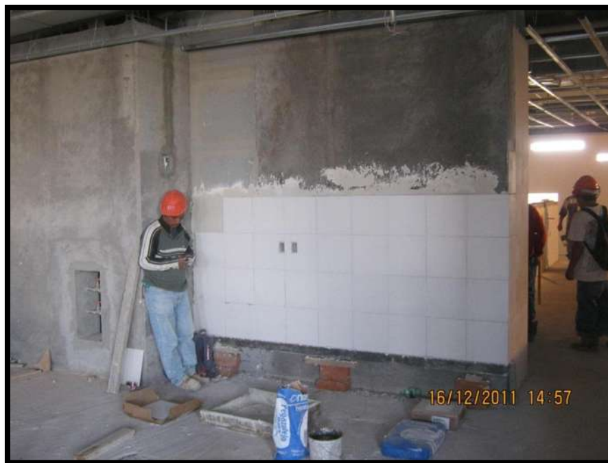
Figura 068. Imagen de Verificación de Colocación de Recubrimiento de Loseta Cerámica en Muros en el Área de Nutrición y Dietética en Sótano 1 del Módulo de Consulta Externa. Fuente: Víctor Hugo Servín Fuentes. [2011]
