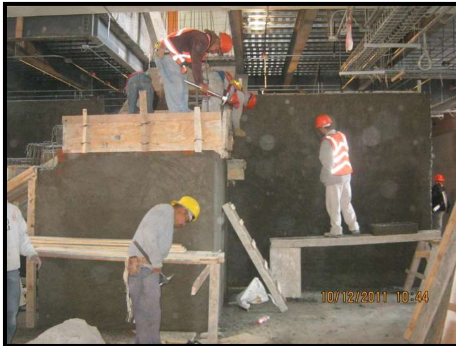
Figura 062. Imagen de Verificación de Aplanados en el Área de Baños Vestidores en Sótano 1 del Módulo de Consulta Externa. Fuente: Víctor Hugo Servín Fuentes. [2011]
