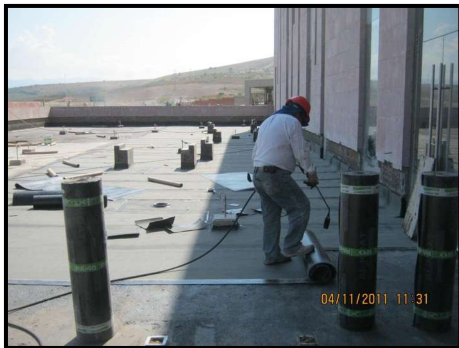
Figura 066. Imagen de Verificación de Colocación de Impermeabilizante para Recibir Piso Pórfido en el Área de Terraza en Primer Nivel del Módulo de Consulta Externa. Fuente: Víctor Hugo Servín Fuentes. [2011]
