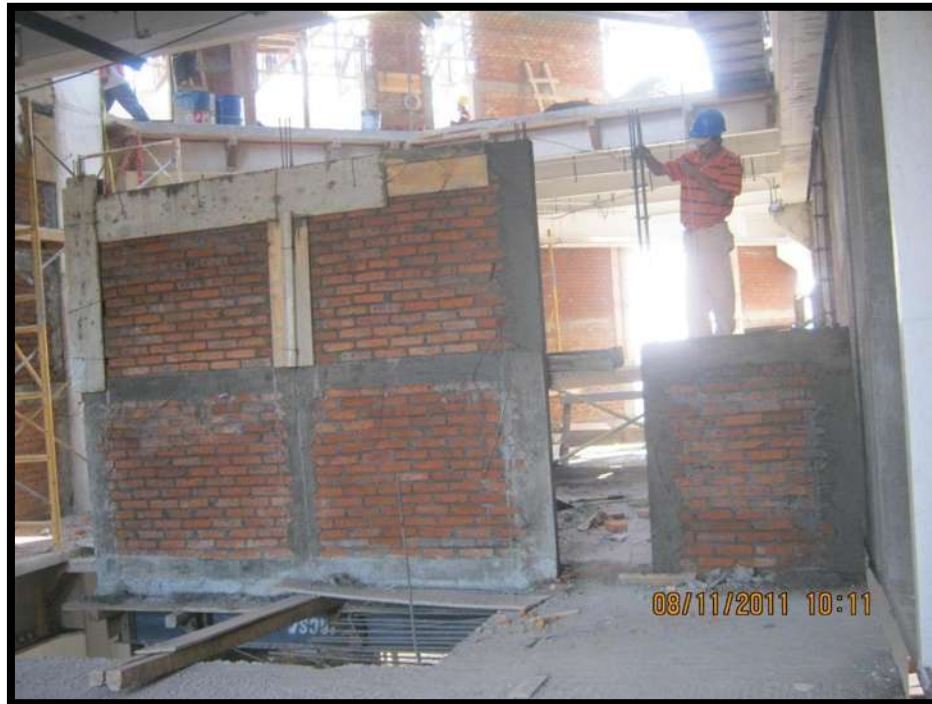
Figura 059. Imagen de Verificación de Albañilerías en el Área de Puentes del Módulo de Consulta Externa Planta Baja. Fuente: Víctor Hugo Servín Fuentes. [2011]
