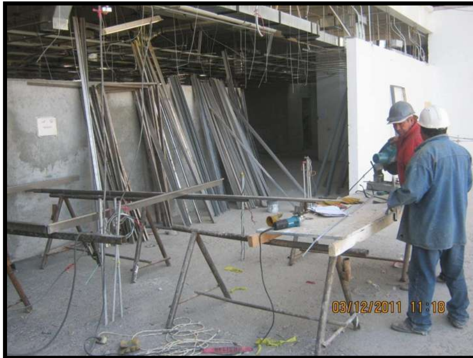
Figura 055. Imagen de Talleres de Fabricación de marcos y chambranas para puertas dentro de la Obra. Fuente: Víctor Hugo Servín Fuentes. [2012]
