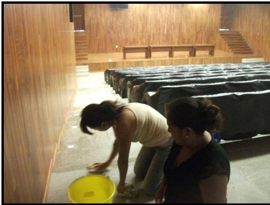
Figura 090. Imagen de Limpieza Final para Entrega en el Área de Auditorio, Sótano 1 del Módulo de Medicina Física. Fuente: Víctor Hugo Servín Fuentes. [2012]
