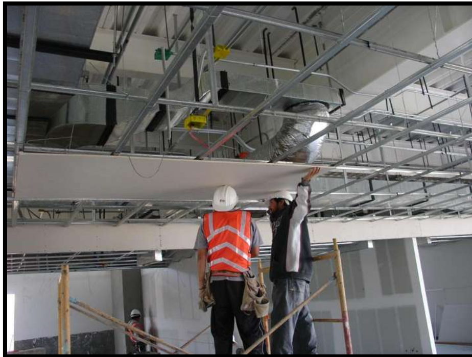
Figura 065. Imagen de Verificación de Colocación de Placas de Yeso en Plafón en el Área de Consultorios en Tercer Nivel del Módulo de Consulta Externa. Fuente: Víctor Hugo Servín Fuentes. [2012]
