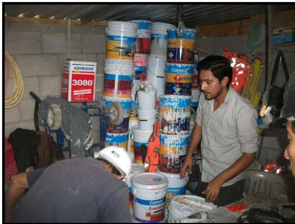
Figura 056. Imagen de Verificación de Bodega de Pinturas. Fuente: Víctor Hugo Servín Fuentes. [2012]
