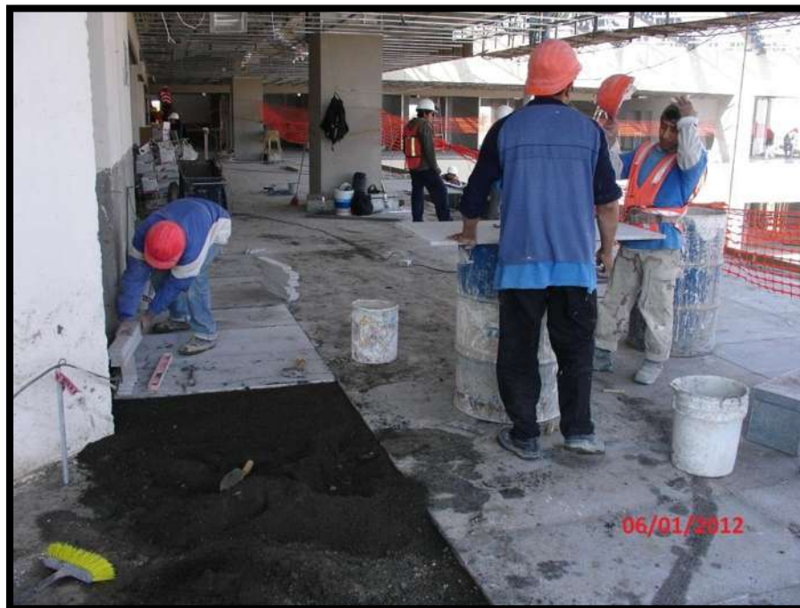
Figura 064. Imagen de Verificación de la Colocación del Piso de Granito en el Tercer Nivel del Módulo de Consulta Externa. Fuente: Víctor Hugo Servín Fuentes. [2012]
