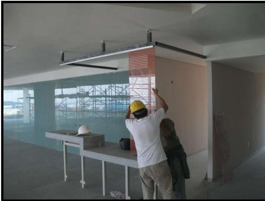
Figura 071. Imagen de Verificación de Colocación de Cancelería de Cristal en Muebles de Control en el Área de Consultorios en Tercer Nivel del Módulo de Consulta Externa. Fuente: Víctor Hugo Servín Fuentes. [2012]
