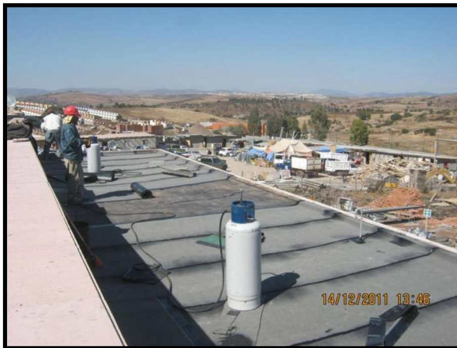
Figura 046. Imagen Panorámica de Bodegas de Materiales y Talleres de Fabricación dentro de la Obra. Fuente: Víctor Hugo Servín Fuentes. [2012]
