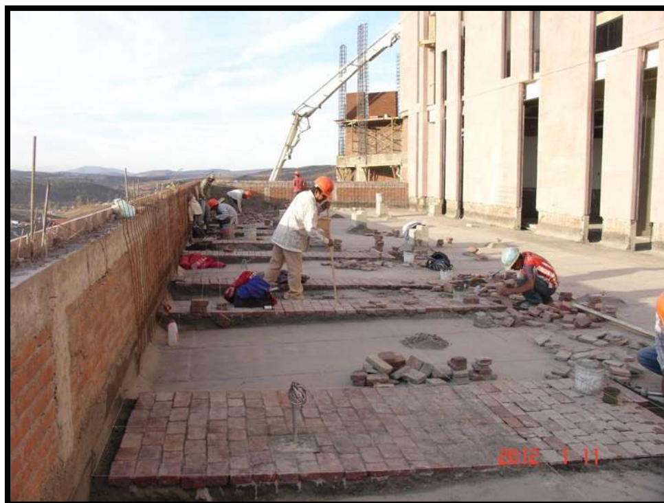
Figura 070. Imagen de Verificación de Colocación de Piso Pórfido en El Área de Terraza en Primer Nivel del Módulo de Consulta Externa. Fuente: Víctor Hugo Servín Fuentes. [2011]
