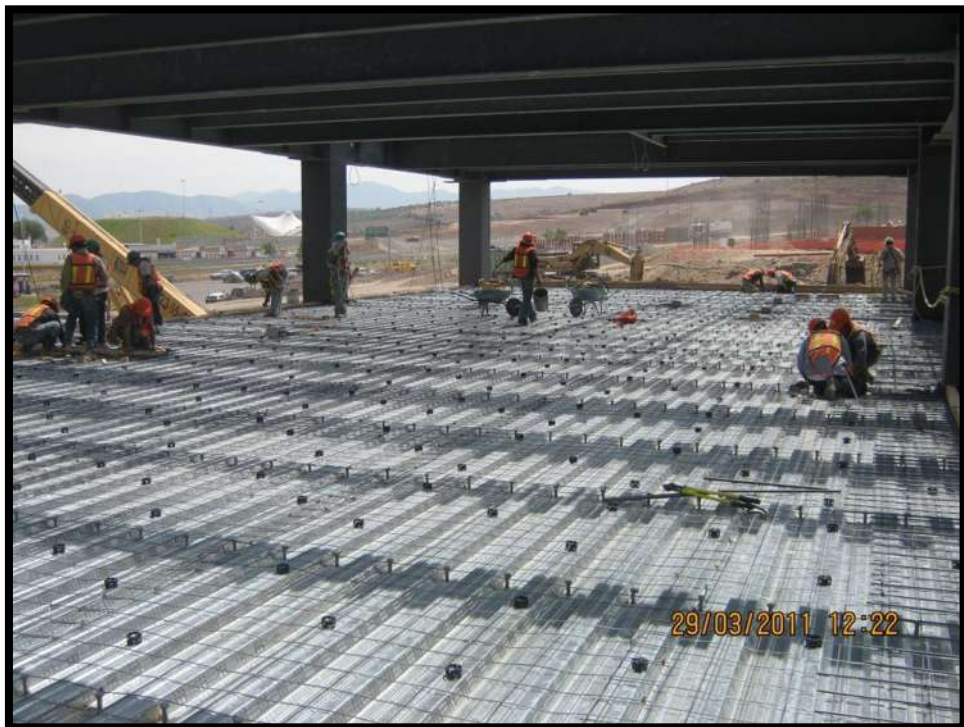
Figura 044. Colocación de Losacero. Fuente: Consultores de la Obra Publica S. C. [2011]
