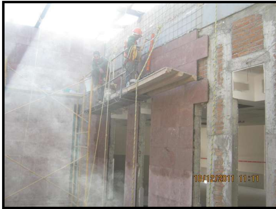
Figura 063. Imagen de Verificación de Colocación de Recubrimiento de Cantera en Muros de Fachada en el Área de Terraza Interior del Módulo de Medicina Física. Fuente: Víctor Hugo Servín Fuentes. [2011]
