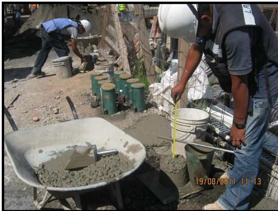
Figura 053. Imagen de Pruebas de Revenimiento de Concreto, Extracción de Corazones de Concreto en Azotea del Módulo de Consulta Externa. Fuente: Consultores de la Obra Publica S. C. [2011]
