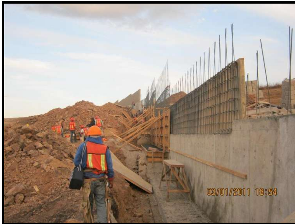
Figura 041. Construcción de Barda Perimetral. Fuente: Consultores de la Obra Publica S. C. [2011]
