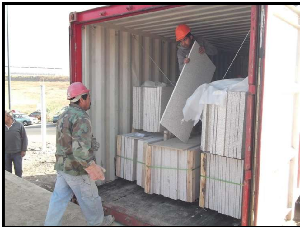
Figura 051. Imagen de Suministro de Piso de Granito a Obra. Fuente: Víctor Hugo Servín Fuentes. [2011]
