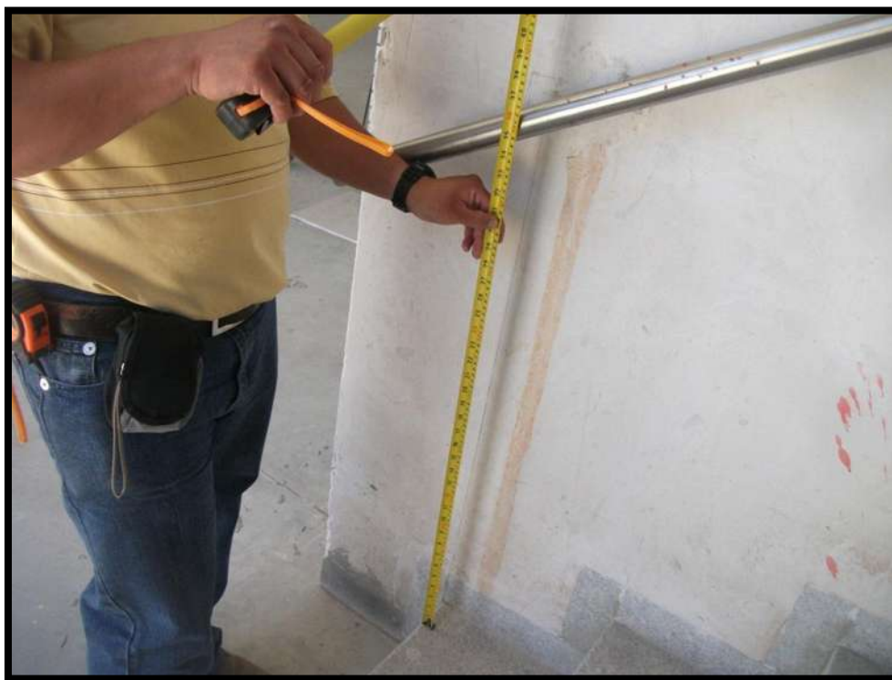
Figura 078. Imagen de Levantamiento de Colocación de Barandal de Acero Inoxidable en Escalera de Emergencia del Módulo de Consulta Externa. Fuente: Víctor Hugo Servín Fuentes. [2012]
