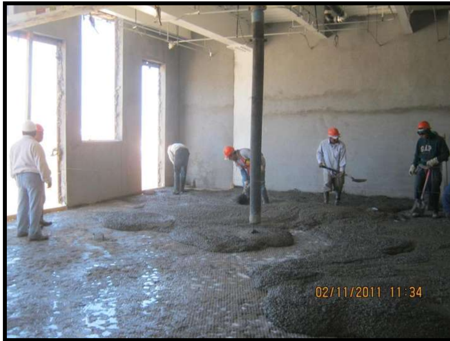
Figura 057. Imagen de Verificación de Colado de Sobre firme en el Área de Cuarto para Equipos de Aire acondicionado en Planta Baja del Módulo de Consulta Externa. Fuente: Víctor Hugo Servín Fuentes. [2011]
