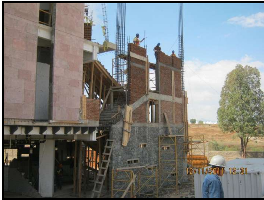
Figura 061. Imagen de Verificación de Albañilerías en Escalera de Emergencia del Módulo de Consulta Externa. Fuente: Víctor Hugo Servín Fuentes. [2011]
