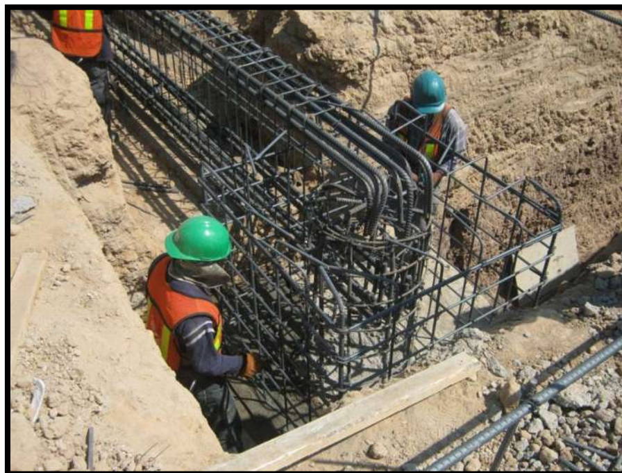
Figura 042. Armado de Cimentaciones. Fuente: Consultores de la Obra Publica S. C. [2011]
