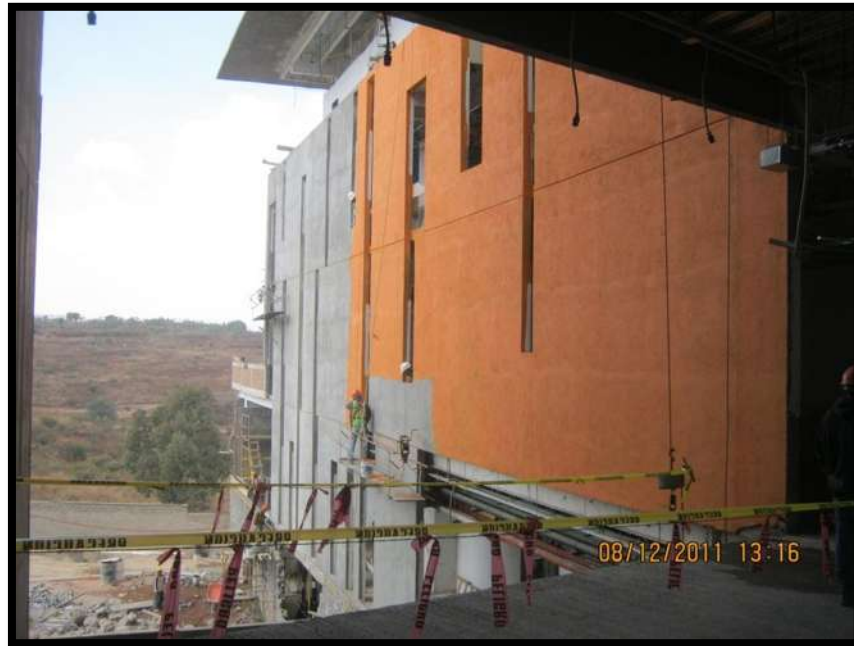
Figura 069. Imagen de Verificación de Aplicación de Pintura en Muros de Fachada del Módulo de Consulta Externa. Fuente: Víctor Hugo Servín Fuentes. [2011]
