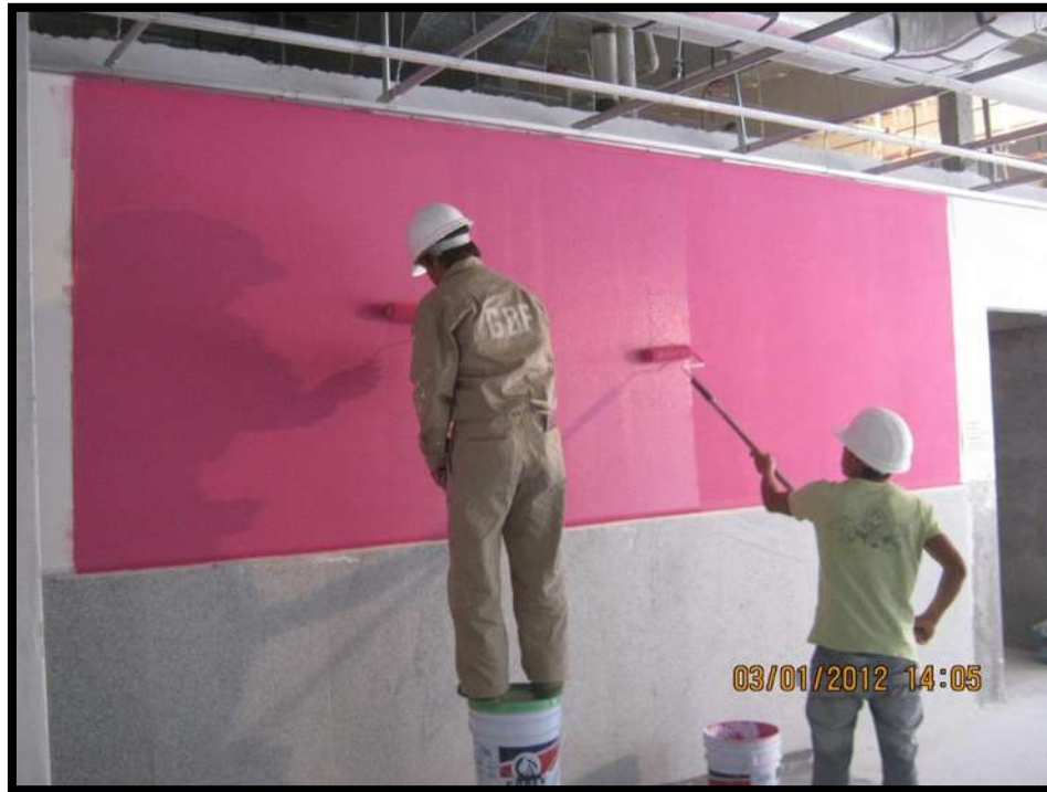
Figura 067. Imagen de Verificación de Aplicación de Pasta en Muros en el Área de Sala de Espera en Sótano 1 del Módulo de Medicina Física. Fuente: Víctor Hugo Servín Fuentes. [2012]
