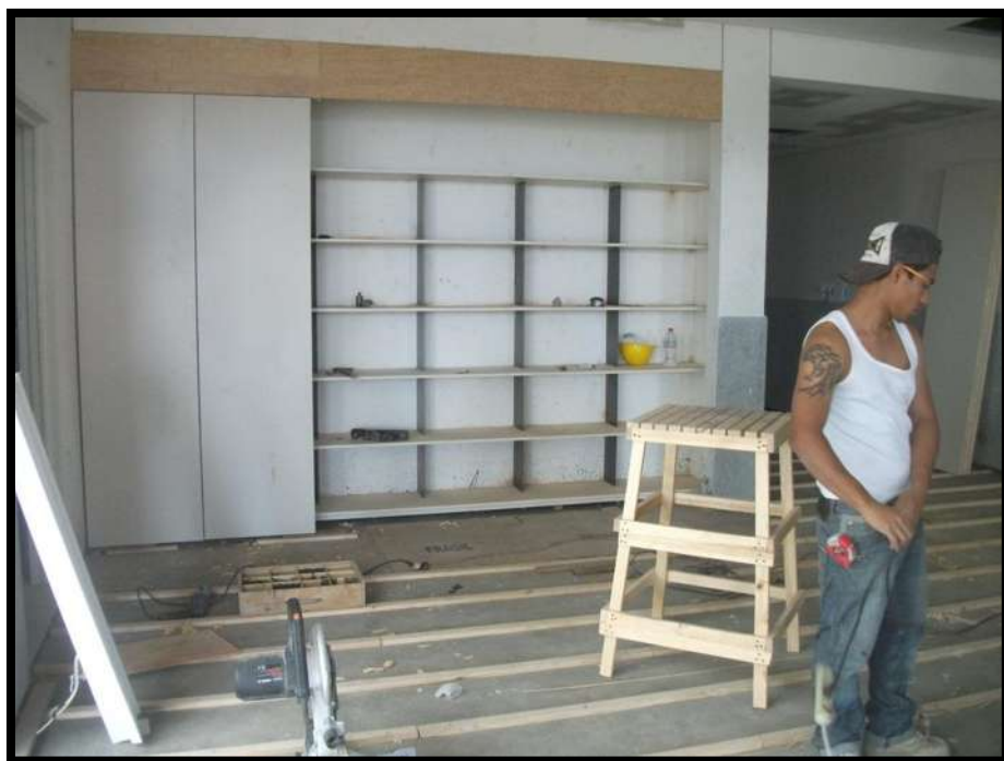
Figura 072. Imagen de Verificación de Colocación de Closet para Guarda de Madera en el Área de Mecanoterapia en Sótano 1 del Módulo de Medicina Física. Fuente: Víctor Hugo Servín Fuentes. [2012]
