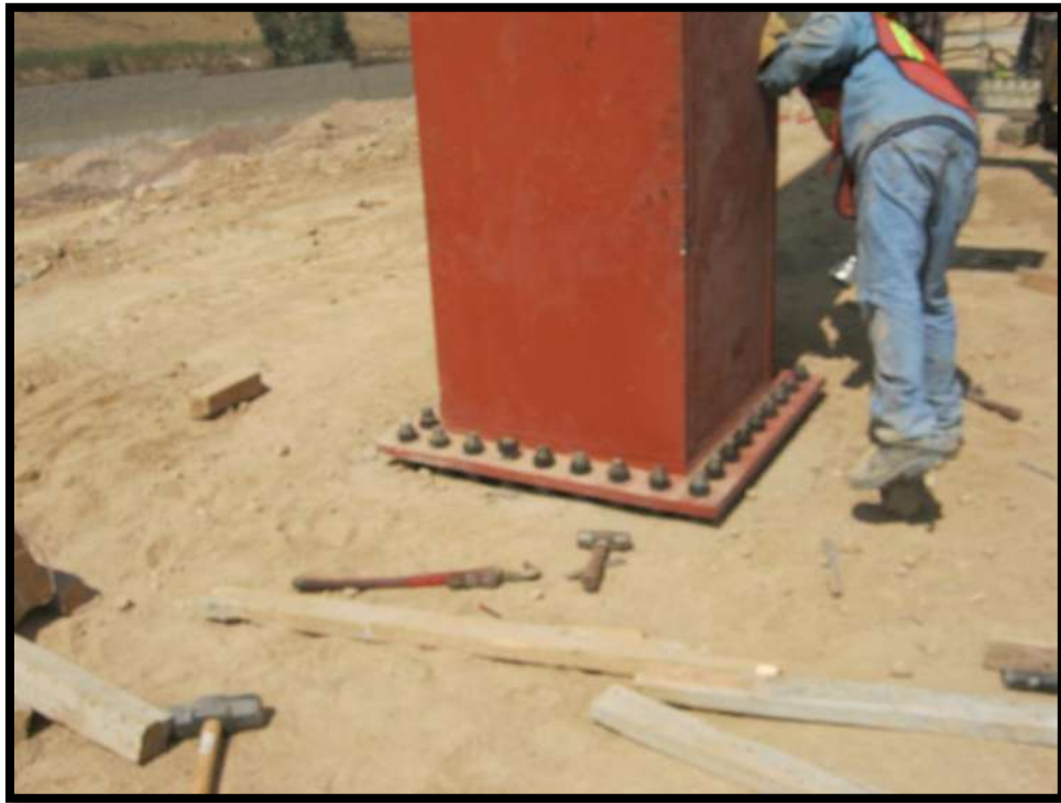
Figura 043. Colocación de Columnas Metálicas. Fuente: Consultores de la Obra Publica S. C. [2011]
