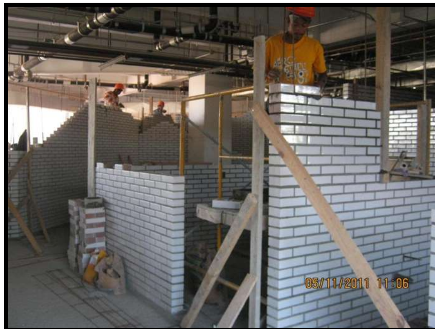
Figura 060. Imagen de Verificación de Albañilerías de Muros de Block Vidriado en el Área de Talleres de Conservación en Sótano 2 del Módulo de Consulta Externa. Fuente: Víctor Hugo Servín Fuentes. [2011]
