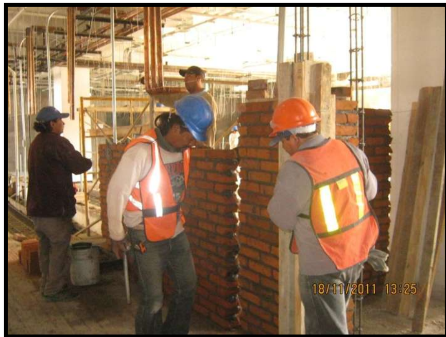
Figura 058. Imagen de Verificación de Albañilerías en el Área de Lavandería en Sótano 1 del Módulo de Consulta Externa. Fuente: Víctor Hugo Servín Fuentes. [2011]
