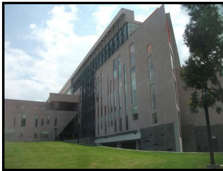
Figura 038. Imagen del Edificio de Consulta Externa. Fuente: Víctor Hugo Servín Fuentes. [2012]
