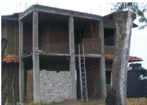
Foto 17: Fotos Carlos Manuel Cabrera Hernández (construcción de adobe)
