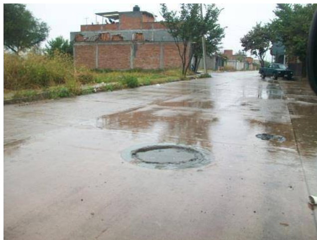
Foto 8: Servicios de alcantarillado y red hidráulica. Fotos: Carlos Manuel Cabrera Hernández.
