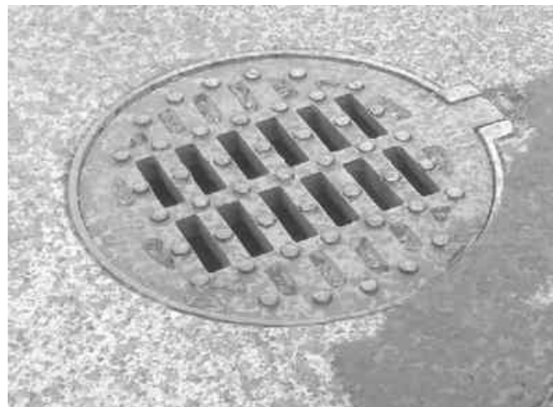
Imagen: N° 63 Servicio De Alcantarillado Tomada por (Ma. De Lourdes Sánchez Aguirre). Junio 2013.
