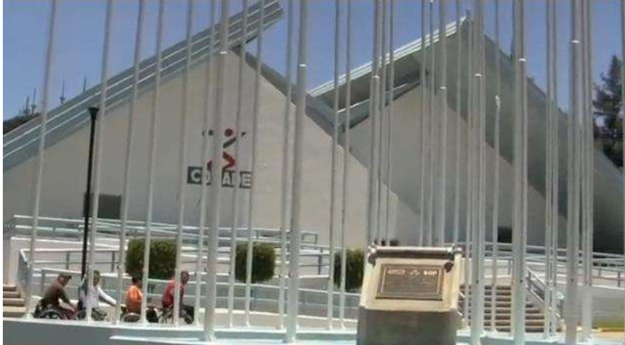
Imagen 19.- Fachada Principal del Centro.
