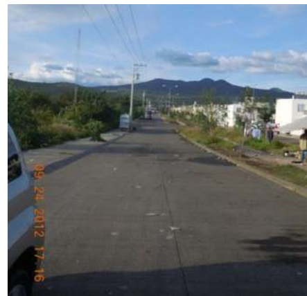
Imagen 45.- Vialidad principal. Foto tomada por HBC.
