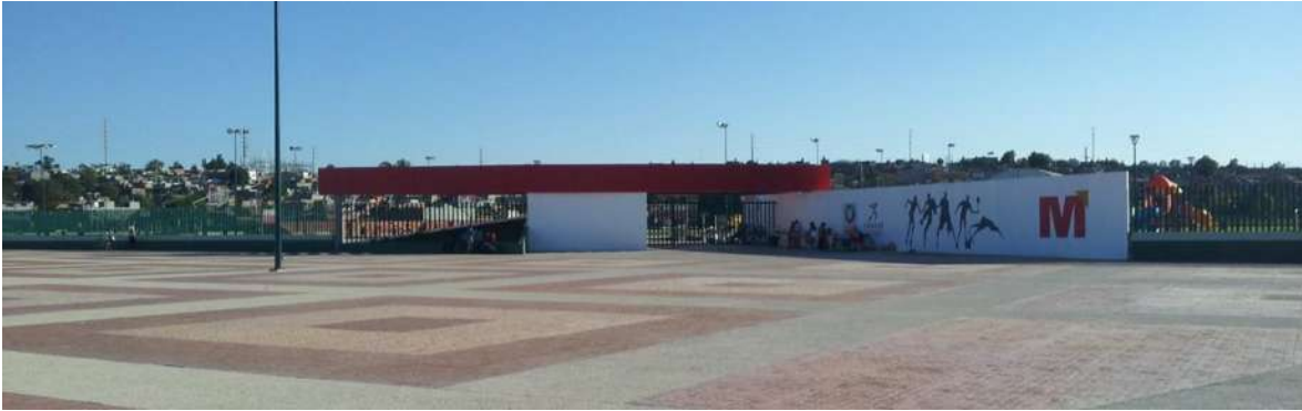
Imagen 14.- Fachada Principal de la unidad deportiva. Foto tomada por HBC.
