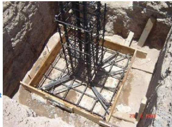
Imagen 65.- Armado de zapata aislada. http://www.arqhys.com/construcciones/fotos/construcciones/Procesos-constructivos-de-una-zapata-aislada.jpg
