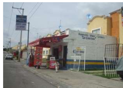
Imagen 51.-Equipamiento de Abasto. Tomada por HBC.
