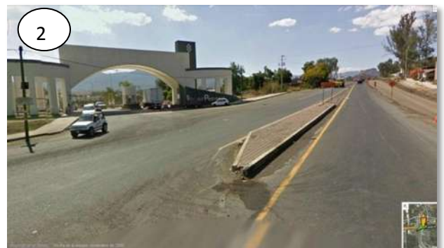
Imagen 48.- Acceso del Fraccionamiento. Tomada por HBC.
