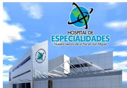
Fig. 5, Unidades de tercer nivel. Hospital de especialidades, en estos edificios se brinda la atención de manera específica hacia alguna parte del cuerpo o de alguna enfermedad en particular.
