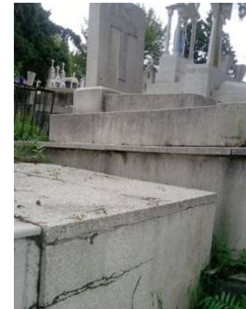
Ilustración 2 Fotografía del Panteón San Antonio, por ser el más antiguo de la ciudad se observa el deterioro que existe en las tumbas.
