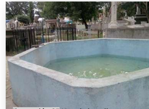
Ilustración 25 Una de las pilas que almacena el agua para las flores y mantenimiento de las tumbas.
