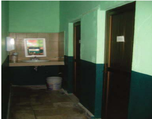
Baños H y M 1
