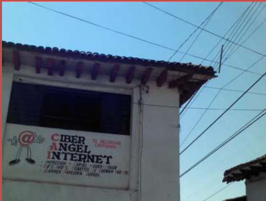
AD-03. Contaminación visual por postes y cableado aéreo.
