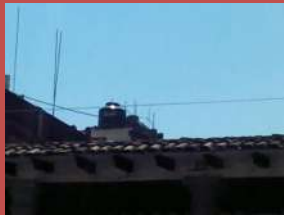
AD-017. Tinacos sin camuflaje.
