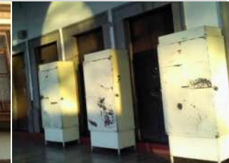
AD-019. Objetos que obstruyen la visibilidad del edificio.
