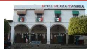
AD-08. Contaminación visual por toldos en fachadas.
