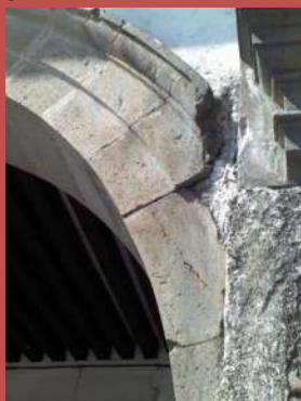
AD-01. Baldosas de piedra dañadas y desniveladas.
