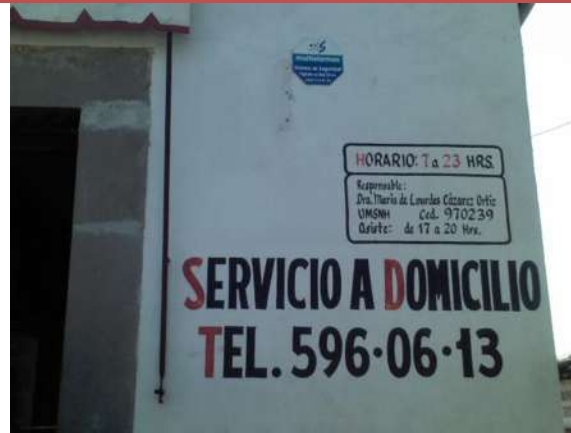
AD-07. Saturación de publicidad en fachadas.
