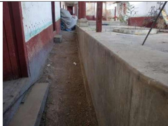
Imagen 94. Corredor, falta de piso de cantería. Foto. Iriele Suárez González.
