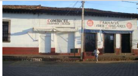
AD-09. Materiales y diseños discordantes en puertas y ventanas.
