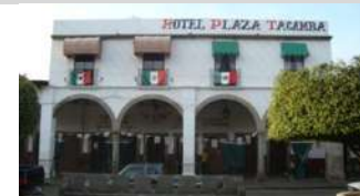
AD-021. Edificio discordante.
