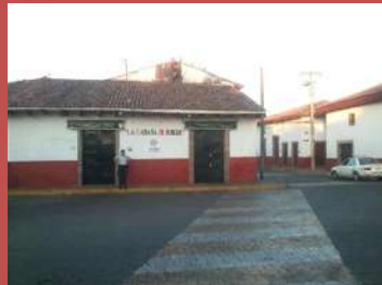
AD-08. Contaminación visual por toldos en fachadas.
