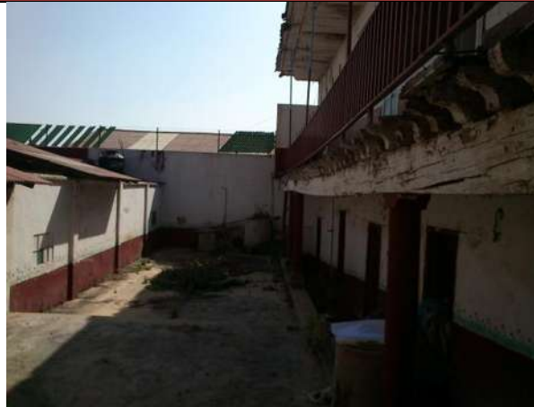
Imagen 92, 93. Vista del patio central y corredor, viguería y gualdra deterioradas. Foto. Iriele Suárez González.
