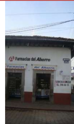
AD-08. Contaminación visual por toldos en fachadas.
