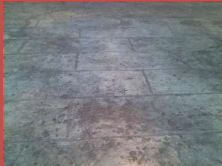
AD-02. Corredor de material discordante.
