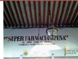
AD-07. Saturación de publicidad en fachadas.
