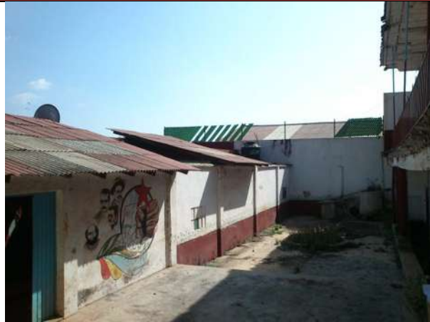
Imagen 91. Vista del patio central, modificado y deteriorado. Foto. Iriele Suárez González.
