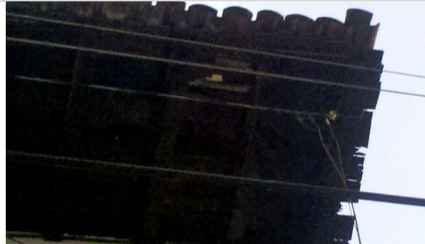
AD-015. Elementos de madera deteriorados.
