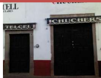
AD-08. Contaminación visual por toldos en fachadas.
