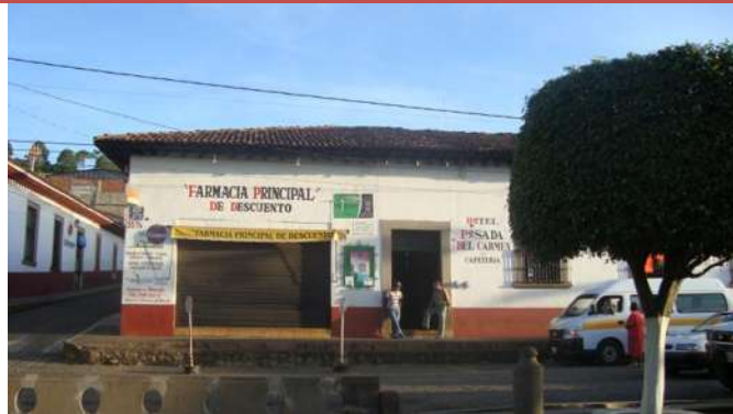
AD-04. Alteraciones en vanos en puertas y ventanas.
