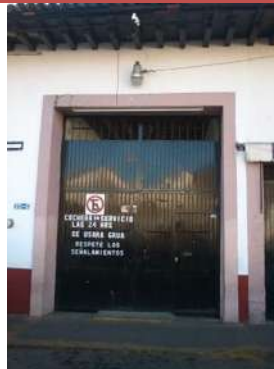
AD-08. Contaminación visual por toldos en fachadas.
