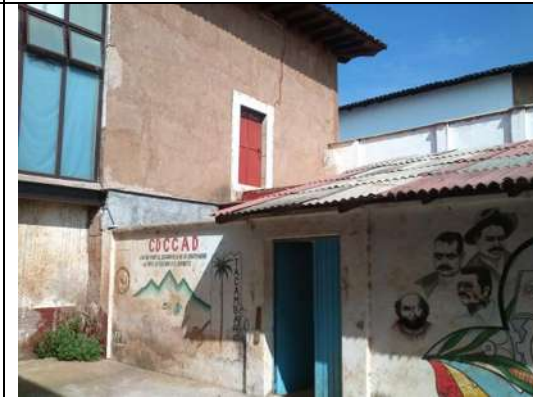
Imagen 90. Vista del patio central al área de servicio que conduce al acceso por la calle Hidalgo Sur, se puede apreciar el cambio de sistemas constructivos. Foto. Iriele Suárez González.
