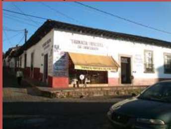
AD-08. Contaminación visual por toldos en fachadas.
