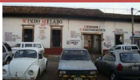
AD-07. Saturación de publicidad en fachadas.
