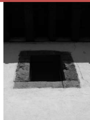
AD-010. Disgregación del material de junteo en elementos de cantería.
