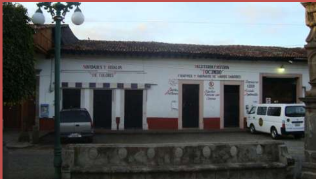
AD-09. Materiales y diseños discordantes en puertas y ventanas.
