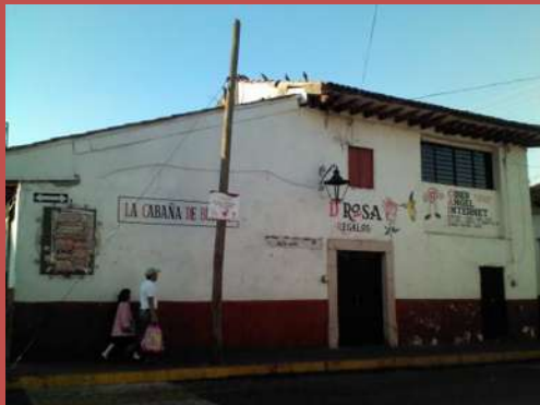
AD-09. Materiales y diseños discordantes en puertas y ventanas.
