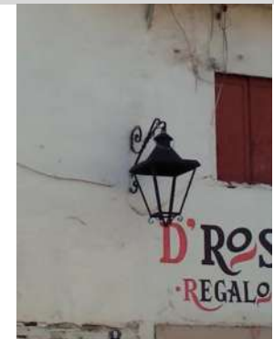
AD-018. Luminaria en mal estado.
