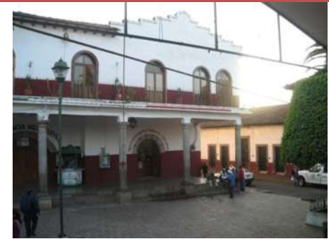
AD-021. Edificio discordante.
