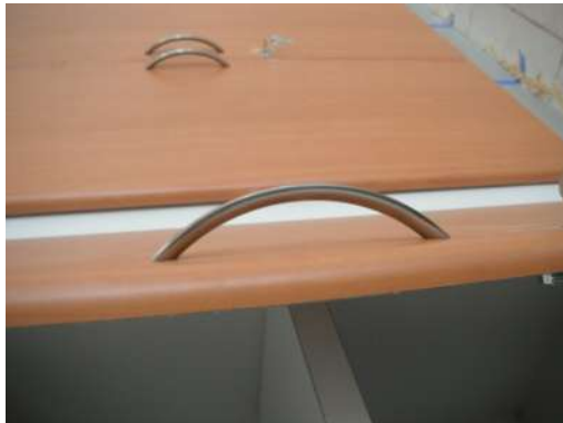
IMAGEN 139 Colocación de jaladeras curvas marca Hafele en guardas. P.B, 1°, 2°, 3er nivel
