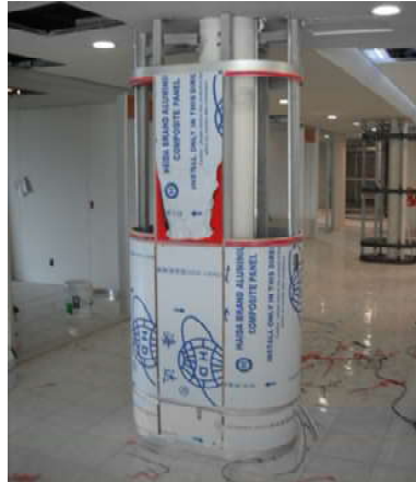
IMAGEN 089 Colocación de forro de Dibond en columnas y escaleras. Planta Baja.
