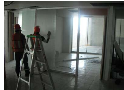
IMAGEN 168 Colocación de crista Saint Gobain en bastidor de cancel sujetado con cinta Norton. P.B, 1°, 2°, 3er nivel
