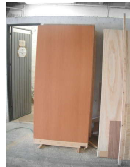
IMAGEN 107 Preparación en parte inferior para colocación de zoclo. P.B, 1°, 2°, 3er nivel
