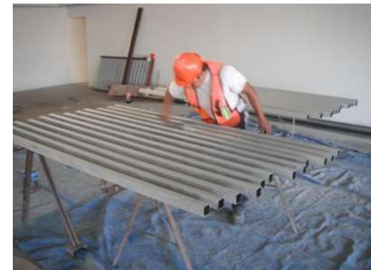
IMAGEN 061 APLICACIÓN DE PRIMARIO A PERFIL PTR ROJO PLANTA BAJA
