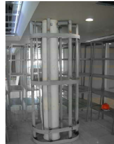
IMAGEN 066 ESTRUTURA TERMINADA PENDIENTE DE RETOQUE PRIMARIO PARA RECIBIR DIBOND PLANTA BAJA
