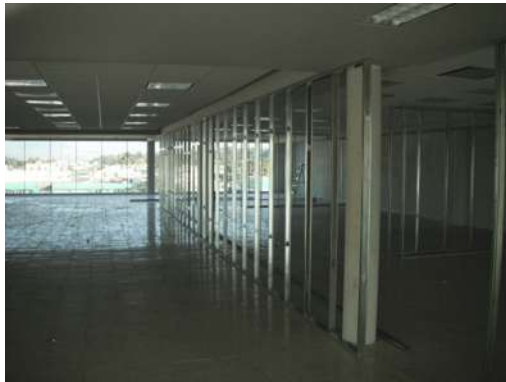
IMAGEN 041 COLOCACION DE BASTIDOR METALICO DE MUROS FALSOS 3ER NIVEL
