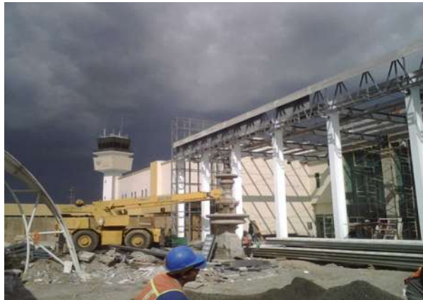
PROCESO DE REMODELACION DE LA TERMINAL AEROPORTUARIA DE MORELIA, MICH.
