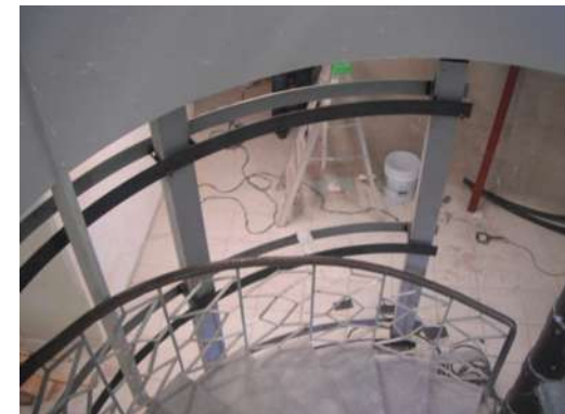
IMAGEN 071 SOLERTRAS COLOCADAS CONFORME A DISEÑO DE PROYECTO PLANTABAJA
