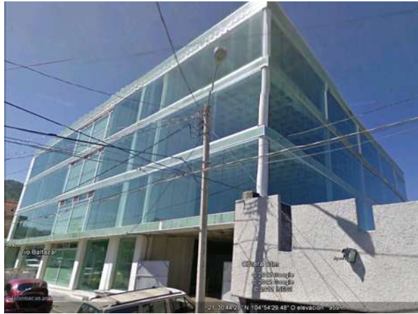
IMAGEN 001 VISTA GENERAL DEL EXTERIOS DEL EDIFICIO
