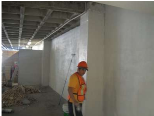
IMAGEN 083 Aplicación de pintura en muros exteriores color blanco ostión. P.B., 1°, 2° 3er nivel.
