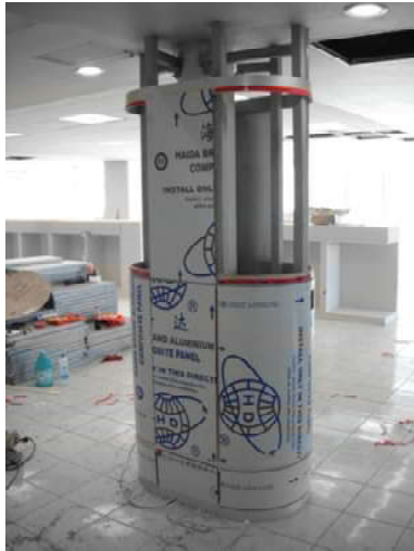
IMAGEN 073 PROCESO DE COLOCACION DE DIBOND EN COLUMNAS PLANTA BAJA
