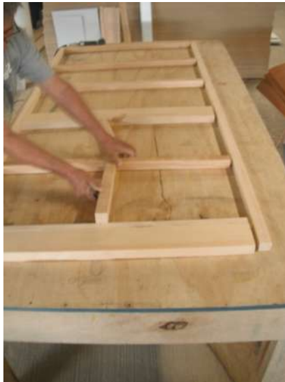
IMAGEN 104 Habilitado de bastidor de puerta. P.B, 1°, 2°, 3er nivel.
