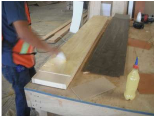
IMAGEN 108 Aplicación de pegamento sobre área de contacto de triplay. P.B, 1°, 2°, 3er nivel
