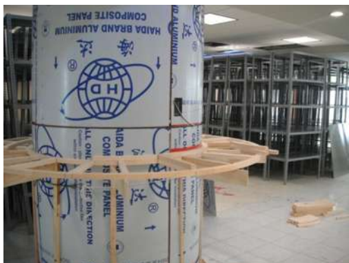
IMAGEN 074 COLUMNA REDONDA TERMINADA EN ACABADO DOBON PLANTA BAJA
