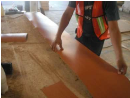
IMAGEN 109 Colocación de laminado plástico sobre triplay. P.B, 1°, 2°, 3er nivel
