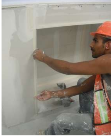
IMAGEN 055 PROCESO DE COLOCACION DE ESQUINERO TIPO PERFATRIM TERCER NIVEL
