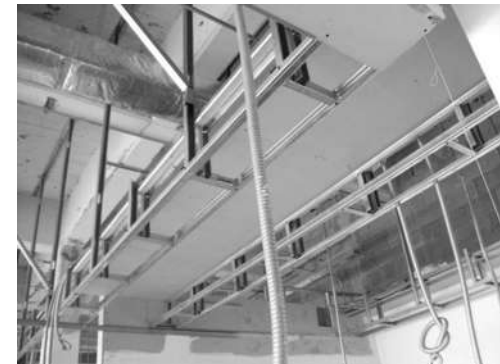
IMAGEN 099 Proceso de fabricación de plafones de ajuste. P.B, 1°, 2°, 3er nivel.
