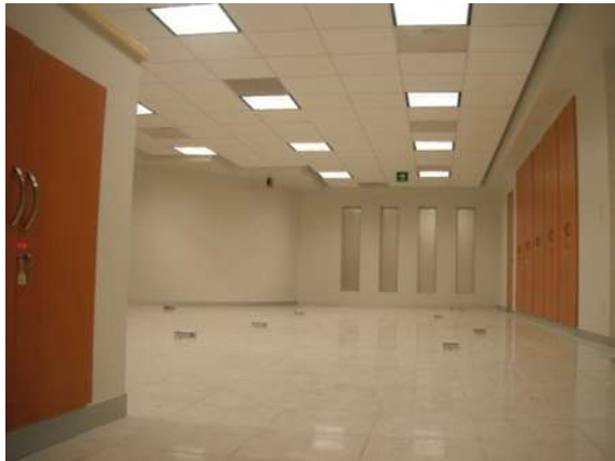
DURANTE EL PROCESO DE REMODELACION DE LA LOCAL DE TEPIC, NAYARIT.
