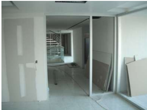
IMAGEN 165 Colocación de bastidor de perfil básico en cancel K-19 para puerta de cristal. P.B, 1°, 2°, 3er nivel
