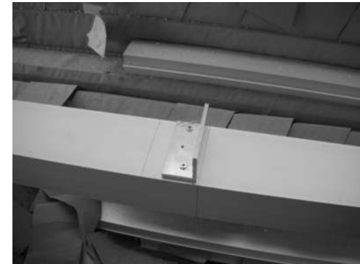
IMAGEN 161 Detalle de unión en perfil de aluminio tipo "T" o escuadra. P.B, 1°, 2°, 3er nivel
