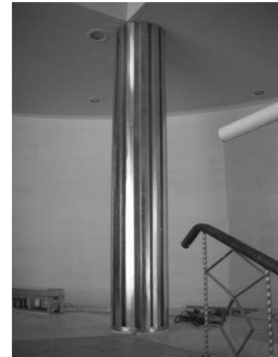
IMAGEN 052 ARMADO DE BASTIDOR PARA COLUMNA CIRCULAR SEGUNDO NIVEL
