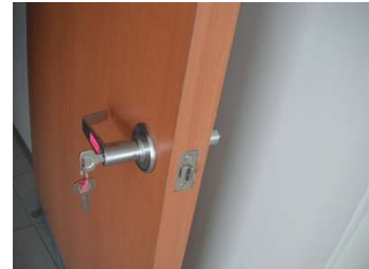
MAGEN 122 Colocación de chapa en puerta de intercomunicación de oficinas. P.B, 1°, 2°, 3er nivel
