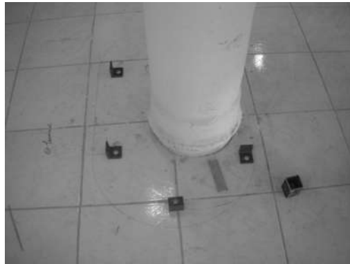
IMAGEN 062 TRAZO PARA BARRENAR Y ANCLAR ANGULOS A PISO PLANTA BAJA
