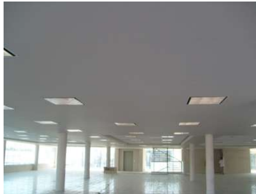
IMAGEN 097 Plafón ciego terminado, pendiente de acabado. P.B, 1°, 2°, 3er nivel.
