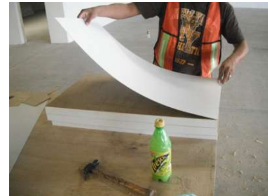
IMAGEN 126 Colocación de laminado plástico sobre bastidor con pegamento de contacto. P.B, 1°, 2°, 3er nivel
