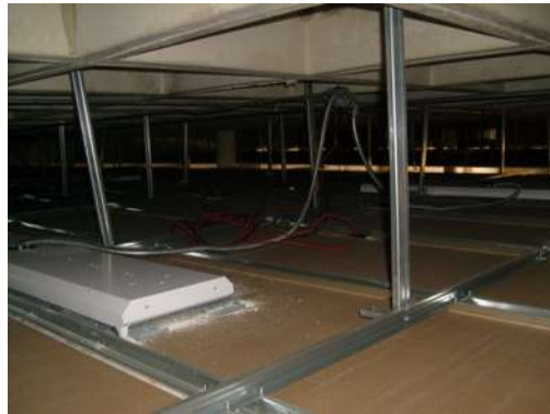
IMAGEN 096 Vista del bastidor y panel yeso colocado de plafón ciego. P.B, 1°, 2°, 3er nivel.
