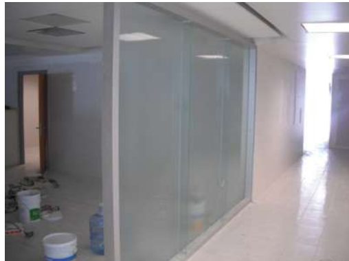
IMAGEN 170 Colocación de costillas cristal templado de 9.5 mm en unión de cristal. P.B, 1°, 2°, 3er nivel
