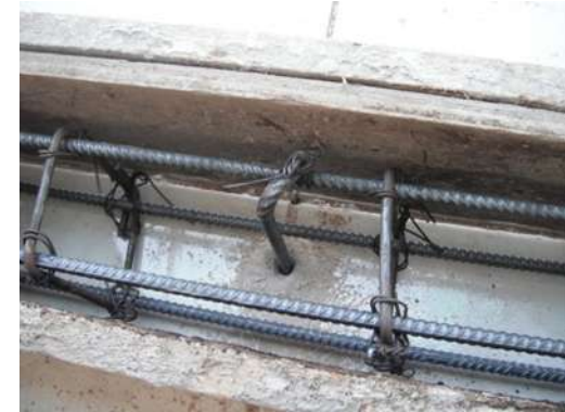
IMAGEN 035 DETALLE DE VARILLA HINCADA A GOLPES EN BARRENO DE 1/2"
