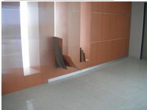
IMAGEN 090 Colocación de zoclo de solera de aluminio en interiores. P.B, 1°, 2°, y 3° nivel.
