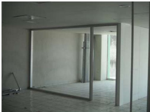
IMAGEN 166 Colocación de bastidor de perfil básico en cancel K-01 para puerta de madera. P.B, 1°, 2°, 3er nivel
