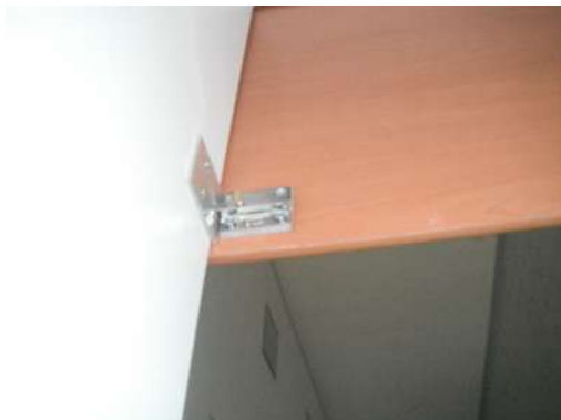
IMAGEN 140 Colocación de pasador marca Philips en guardas. P.B, 1°, 2°, 3er nivel
