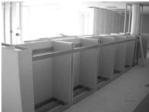
IMAGEN 050 PROCESO DE FABRICACION DE GUARDAS BAJAS P.B., 1°, 2° Y 3 ER NIVEL
