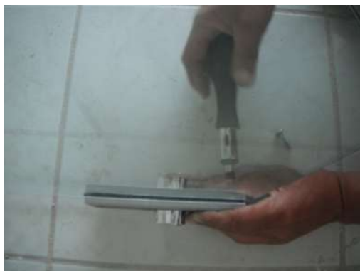
IMAGEN 178 Colocación de cerradura CR Laurence mod. AMR 205A en puerta de cristal. P.B, 1°, 2°, 3er nivel
