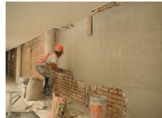
IMAGEN 087 Aplicación de aplanados de mortero de yeso-agua en muros interiores (acabado fino). Primer Nivel.
