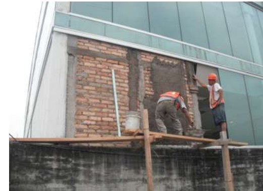
IMAGEN 086 Aplicación de aplanados de mortero cemento-arena en muros exteriores (acabado fino). Primer Nivel.
