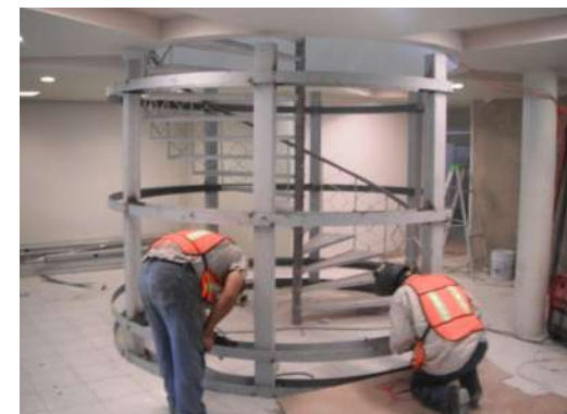
IMAGEN 072 VISTA DE LA ESTRUCTURA PLANTA BAJA
