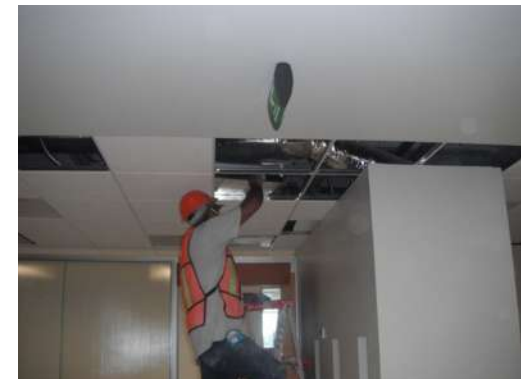
IMAGEN 101 Proceso de armado de plafón registrable. P.B, 1°, 2°, 3er nivel.
