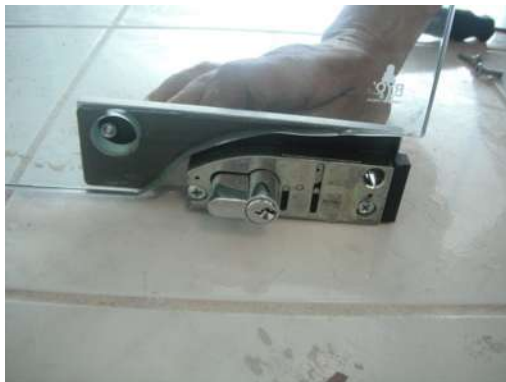
IMAGEN 177 Colocación de cerradura CR Laurence mod. AMR 205A en puerta de cristal. P.B, 1°, 2°, 3er nivel
