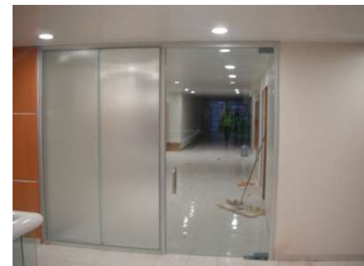
IMAGEN 187 Puerta de cristal templado terminada. P.B, 1°, 2°, 3er nivel
