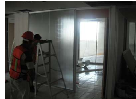
IMAGEN 169 Cristal instalado pendiente de sellado con silicón transparente. P.B, 1°, 2°, 3er nivel
