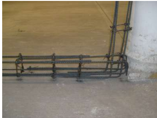
IMAGEN 038 DETALLE DE PROCESO DE ANCLAJE DE CASTILLO COLINDANTE EN CADENA DE DESPLANTE
