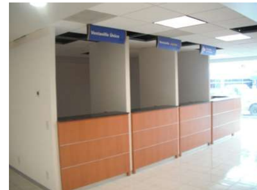
IMAGEN 009 VENTANILLAS PLANTA BAJA
