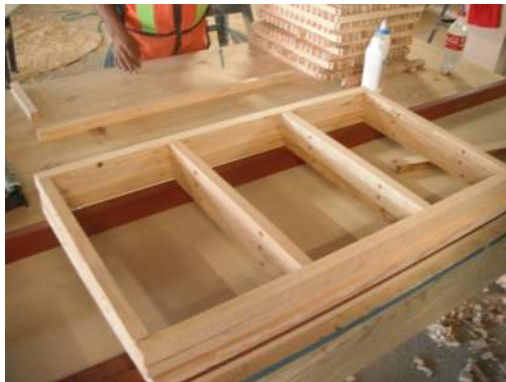
IMAGEN 123 Habilitado de bastidores de madera para entrepaños. P.B, 1°, 2°, 3er nivel
