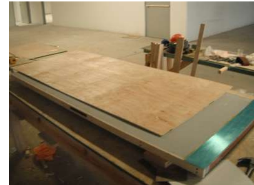
IMAGEN 106 Colocación de forro de triplay de 6mm en ambas caras. P.B, 1°, 2°, 3er nivel
