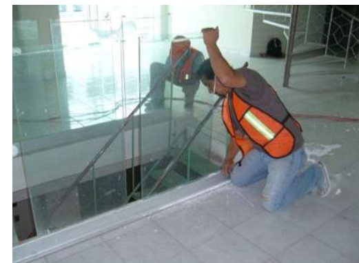
IMAGEN 031 DESMANTELAMIENTO DE BARANDAL PLANTA BAJA
