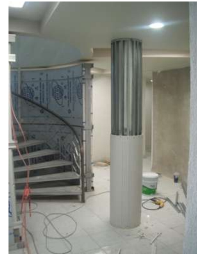
IMAGEN 057 PROCESO DE COLOCACION DE PANEL YESO EN COLUMNA CIRCULAR PLANTA BAJA
