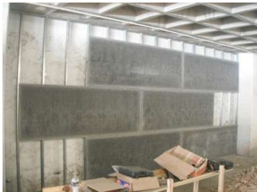
IMAGEN 046 PROCESO DE COLOCACION DE PANELES DE CEMENTO SOTANO
