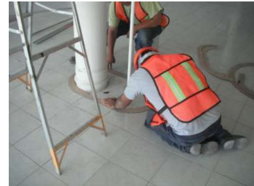
IMAGEN 059 TRAZO PARA ESTRUCTURA DE COLUMNAS PLANTA BAJA
