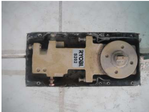
IMAGEN 182 Colocación de bisagra hidráulica ahogada en piso para puerta de cristal. P.B, 1°, 2°, 3er nivel
