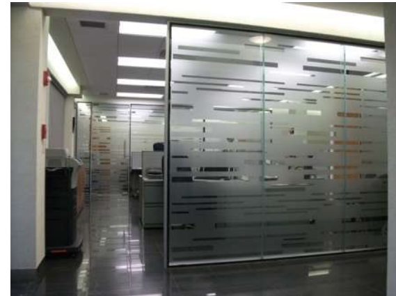
PROCESO DE REMODELACION DE LAS OFICINAS DE LA ADMINISTRACION LOCAL DEL SAT EN REYNOSA, TAMAULIPAS.
