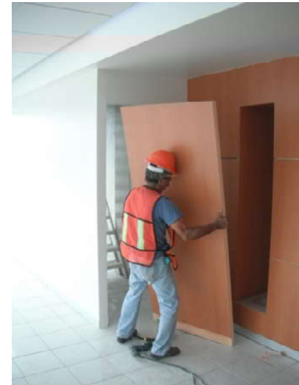
IMAGEN 111 Puerta forrada con laminado plástico en ambas caras de la puerta. P.B, 1°, 2°, 3er nivel
