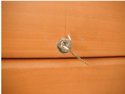
IMAGEN 138 Colocación chapa marca Philips en guardas. P.B, 1°, 2°, 3er nivel
