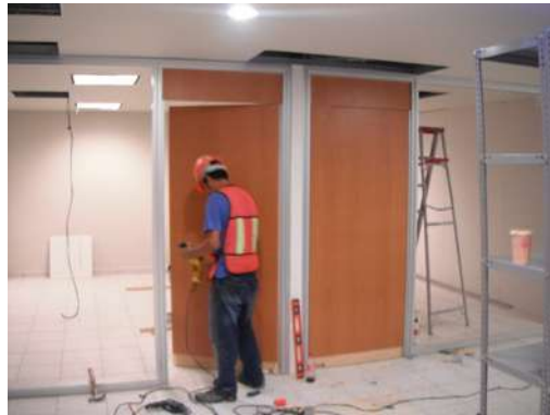
MAGEN 113 Colocación de puerta de madera en cancel de aluminio. P.B, 1°, 2°, 3er nivel
