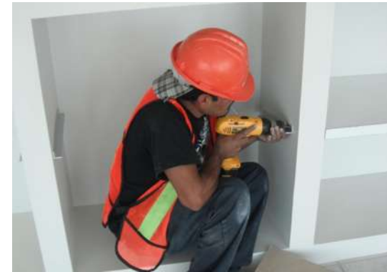
IMAGEN 130 Colocación de soporte de ángulo de aluminio para bastidores de madera. P.B, 1°, 2°, 3er nivel
