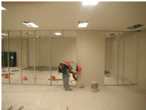
IMAGEN 043 FORRADO DE BASTIDORES METALICOS CON PANELES DE YESO SEGUNDO NIVEL
