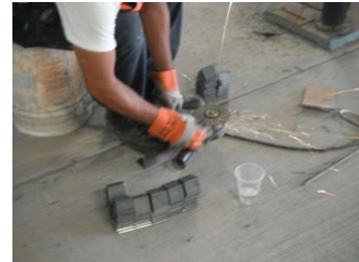
IMAGEN 060 CORTE Y DESBASTE DE REBABA DE ANGULOS PANTA BAJA
