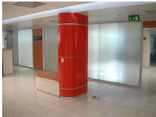
IMAGEN 093 Acabado final en recubrimiento con Dibond color rojo. Planta Baja.
