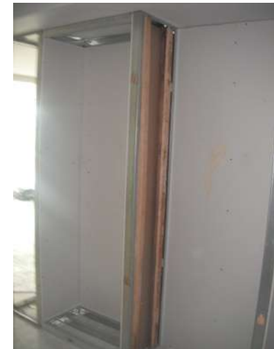
IMAGEN 048 COLOCACION DE REFUERZO DE MADERA (CANES) PARA RECIBIR ENTREPAÑOS DE MADERA P.B., 1º, 2º Y 3 ER NIVEL
