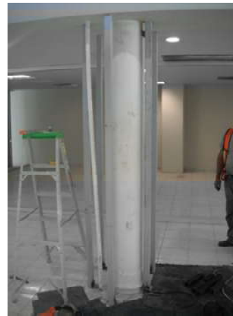
IMAGEN 063 COLOCACION DE PERFILES PTR PARA ESTRUCTURA METALICA PLANTA BAJA
