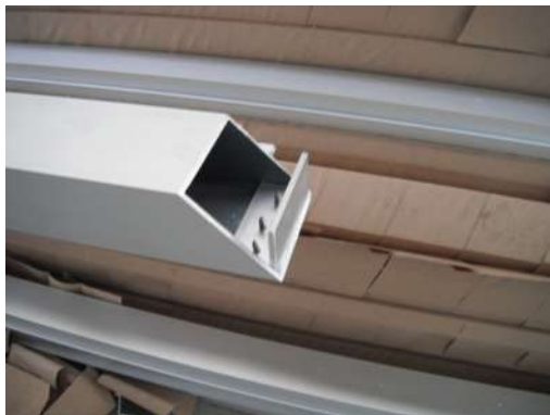
IMAGEN 159 Detalle de unión en perfil de aluminio tipo "L" o escuadra. P.B, 1°, 2°, 3er nivel
