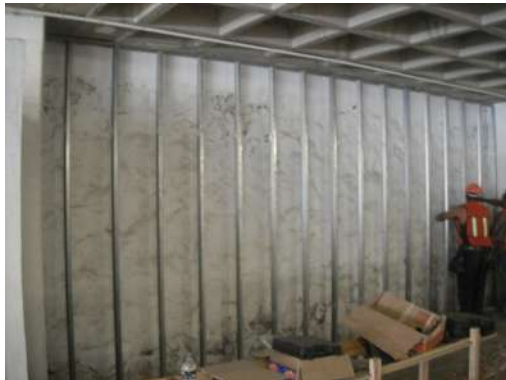
IMAGEN 045 COLOCACION DE ESTRUCTURA EN CALIBRE 20 PARA LAMBRIN DE PANEL CEMENTO SOTANO
