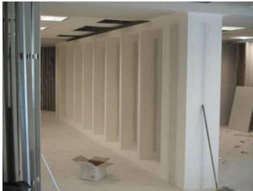
IMAGEN 054 GUARDA ALTA TERMINADA LISTA PARA RECIBIR ACABADO EN PINTURA PRIMER NIVEL
