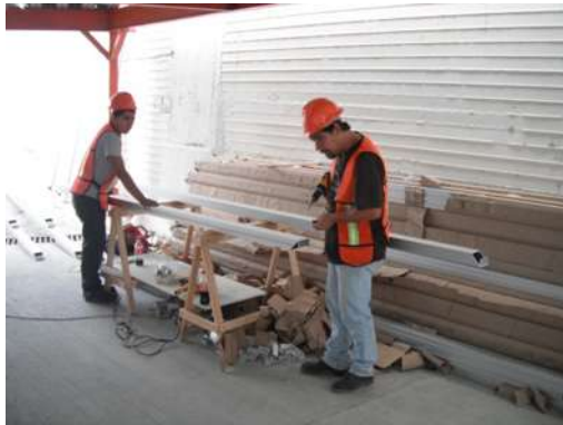
IMAGEN 158 Corte y habilitado de materiales para cancelos en sitio. P.B, 1°, 2°, 3er nivel
