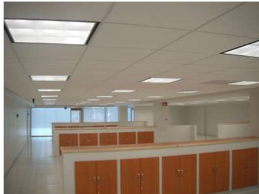
IMAGEN 102 Plafón registrable terminado. P.B, 1°, 2°, 3er nivel.
