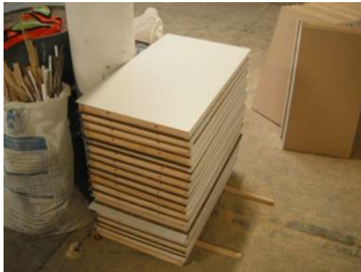
IMAGEN 127 Bastidores ya forrados en ambas caras con laminado plástico. P.B, 1°, 2°, 3er nivel
