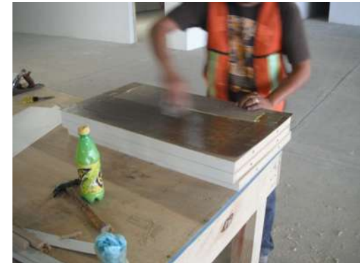
IMAGEN 125 Aplicación de pegamento de contacto para forro con laminado plástico. P.B, 1°, 2°, 3er nivel
