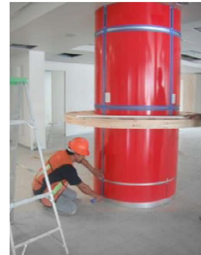
IMAGEN 094 Proceso de sellado de juntas don silicón en recubrimiento con Dibond color rojo. Planta Baja.
