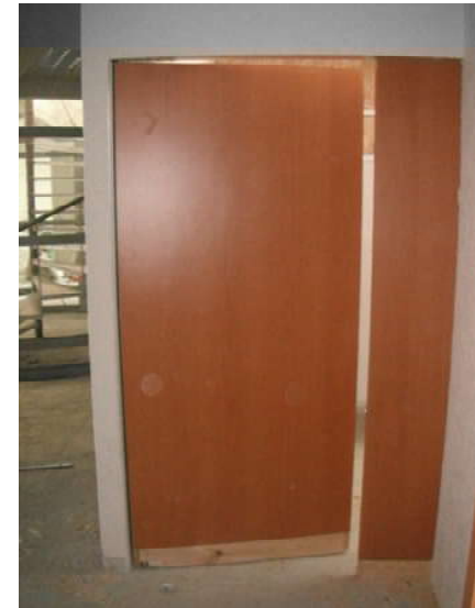
IMAGEN 112 Colocación de puerta de madera en muro de paneles de yeso. P.B, 1°, 2°, 3er nivel
