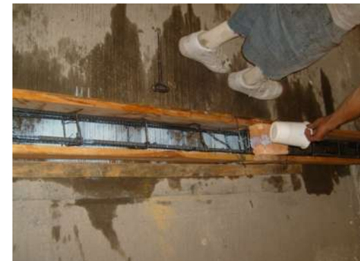
IMAGEN 037 APLICACIÓN DE ADITIVO PARA UNIR CONCRETO EXISTENTE CON NUEVO
