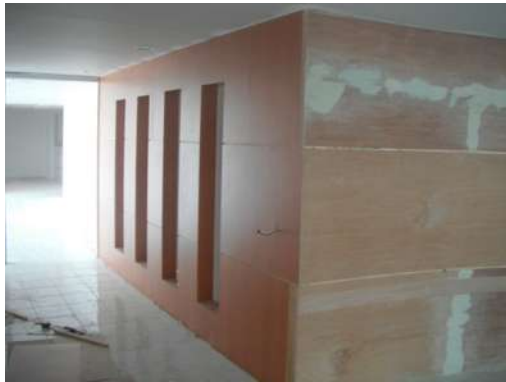
IMAGEN 088 Proceso de colocación de lambrín de madera acabado en formica línea Vosges Pear Matte. P.B, 1°, 2°, y 3° nivel.
