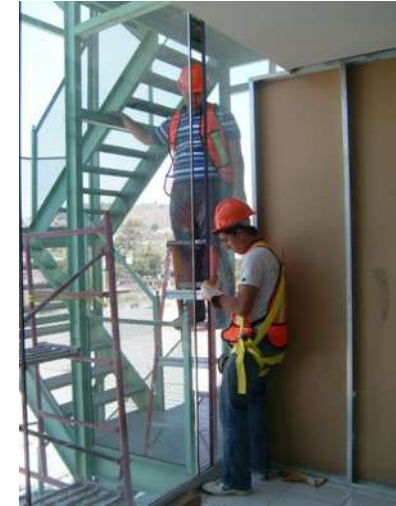
IMAGEN 032 DESMANTEAMIENTO DE FACHADA DE CRISTAL PRIMER NIVEL
