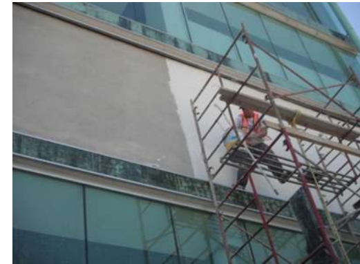
IMAGEN 091 Aplicación de acabado final en muros exteriores. P.B, 1°, 2° nivel.
