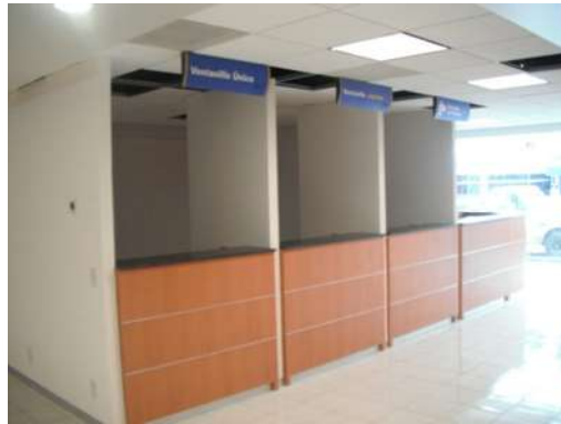
IMAGEN 093 Acabado final muros interiores con pasta texturizada. Planta Baja.
