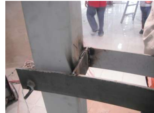
IMAGEN 070 COLOCACION DE SEPARADORES PARA UNIFORMIZAR SEPARACION PLANTA BAJA
