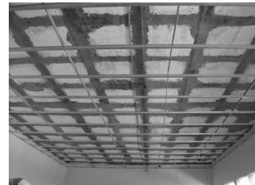
IMAGEN 095 Armado de bastidor para plafón ciego. P.B, 1°, 2°, 3er nivel.
