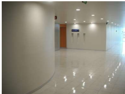
IMAGEN 098 Vista del plafón ciego terminado al 100%. P.B, 1°, 2°, 3er nivel.
