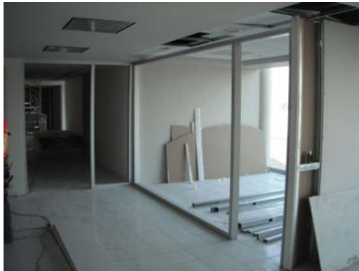
IMAGEN 164 Colocación de bastidor para cancel interior a base de perfil básico. P.B, 1°, 2°, 3er nivel
