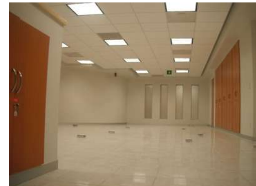
IMAGEN 092 Acabado final en zoclo de solera de aluminio. P.B, 1°, 2°, 3er nivel
