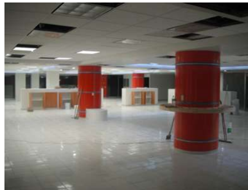
IMAGEN 076 VISTA DE COLUMNAS PLANTA BAJA
