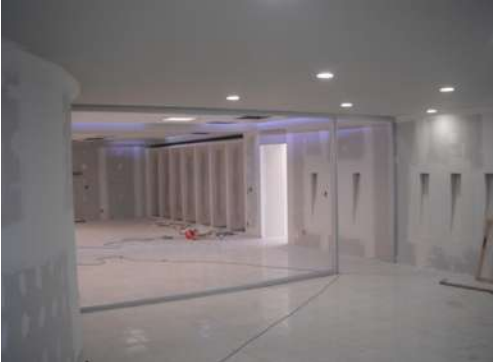
IMAGEN 056 MUROS CON TERMINADO REDIMIX EN JUNTAS ASENTADO CON LIJA PARA RECIBIR ACABADO EN PINTURA TERCER NIVEL
