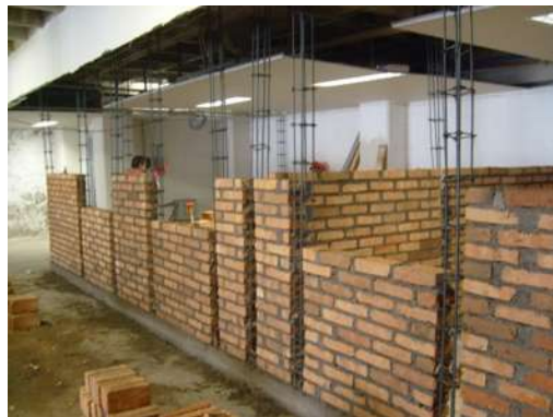
IMAGEN 039 PROCESO DE FABRICACION DE MUROS CASTILLOS Y CADENAS EN SOTANO
