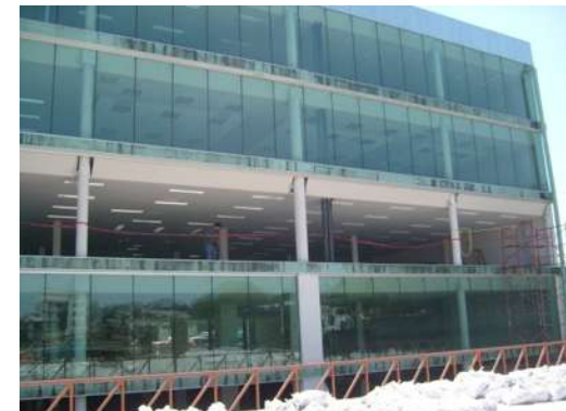
IMAGEN 033 VISTA DE FACHADA POSTERIOR DESMANTELADA PRIMER NIVEL
