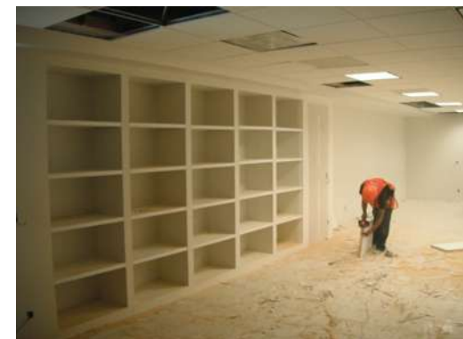
IMAGEN 132 Colocación de bastidores de madera en guarda alta. P.B, 1°, 2°, 3er nivel
