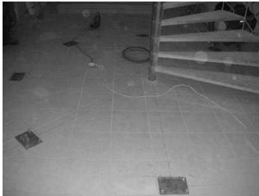
IMAGEN 067 TRAZO Y COLOCACION DE PLACAS DE ACERO PLANTA BAJA
