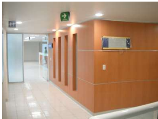
IMAGEN 094 Acabado final en muros de lambrín de formica Vosges Pear Matte. P.B, 1°, 2°, 3er nivel
