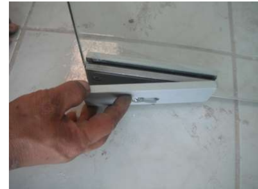
IMAGEN 179 Colocación de cerradura CR Laurence mod. AMR 205A en puerta de cristal. P.B, 1°, 2°, 3er nivel
