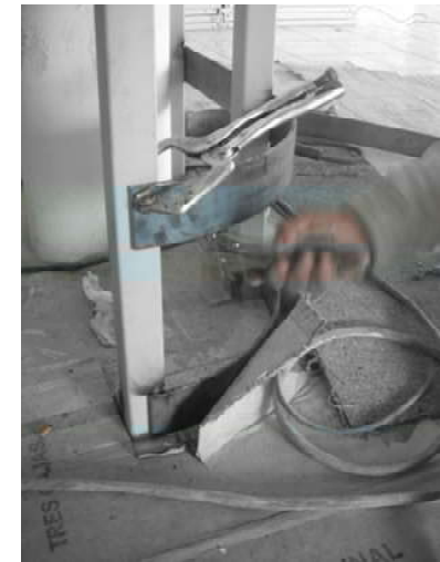
IMAGEN 065 COLOCACION Y SOLDADO DE SOLERA DE 3"X 1/4" ROLADA EN FRIO PLANTA BAJA
