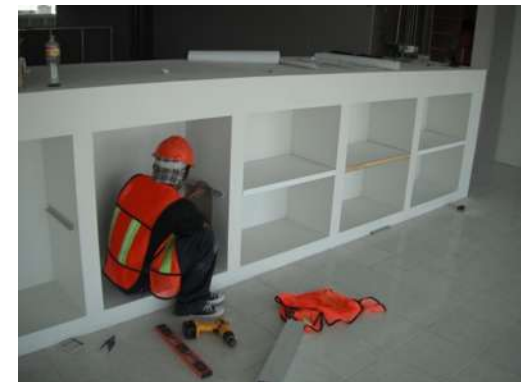
IMAGEN 131 Colocación de bastidores de madera en guarda baja. P.B, 1°, 2°, 3er nivel
