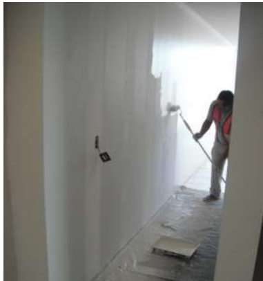
IMAGEN 082 Aplicación de pintura en muros interiores color blanco ostión. P.B., 1°, 2° 3er nivel.
