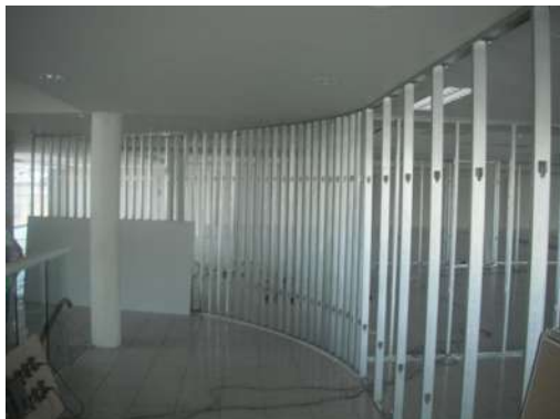
IMAGEN 051 ARMADO DE CASTIDOR DE MURO CURVO SEGUNDO NIVEL
