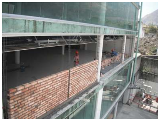
IMAGEN 040 PROCESO DE FABRICACION DE MUROS, CASTILLO Y CADENAS EN PRIMER NIVEL
