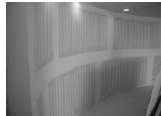
IMAGEN 053 MURO TERMINADO CON ACABADO REDIMIX LIJADO LISTO PARA RECIBIR ACABADO EN PINTURA TERCER NIVEL
