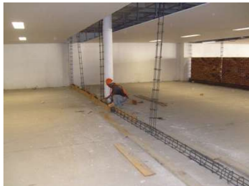
IMAGEN 034 COLOCACION DE ACERO ARMADO PARA CADENA DDE DESPLANTE Y PROCESO DE CIMBRADO
