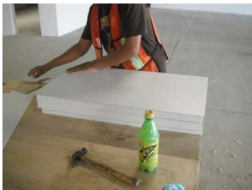
IMAGEN 129 Bastidores terminados con caras visibles aplicado el laminado plástico. P.B, 1°, 2°, 3er nivel
