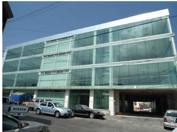
IMAGEN 002 VISTA DE LA FACHADA PRINCIPAL DEL EDIFICIO
