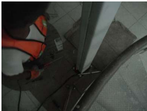
IMAGEN 068 COLOCACION DE COLUMNAS PLANTA BAJA
