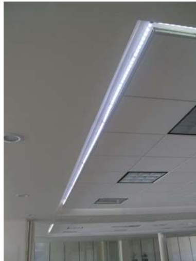
IMAGEN 100 Vista de plafones de ajustes terminados. P.B, 1°, 2°, 3er nivel.
