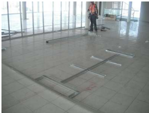
IMAGEN 042 COLOCACION DE DESPLANTE DE BASTIDOR METALICO PARA MUROS FALSOS SEGUNDO NIVEL
