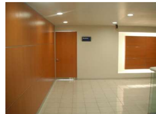
MAGEN 118 Puerta terminada colocada sobre muros falsos de panel yeso. P.B, 1°, 2°, 3er nivel
