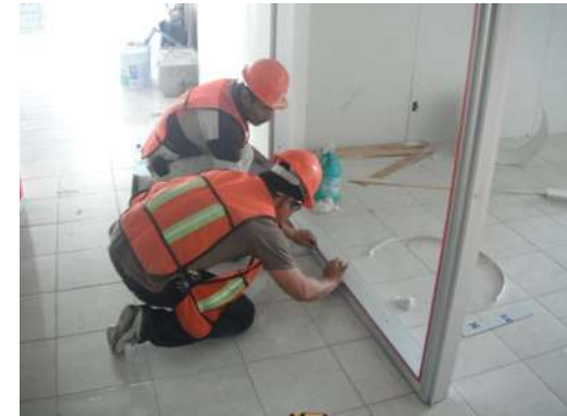
IMAGEN 167 Colocación de Cinta doble cara Norton para recibir cristal. P.B, 1°, 2°, 3er nivel
