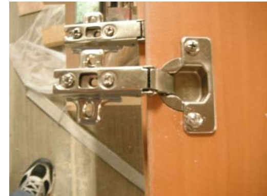
IMAGEN 141 Colocación de bisagra de proyección en guardas. P.B, 1°, 2°, 3er nivel
