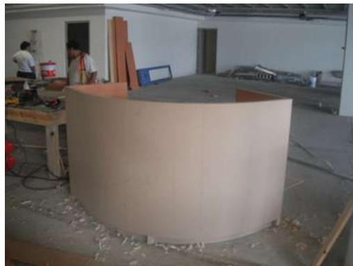
IMAGEN 147 Proceso de fabricación de mueble curvo de recepción. P.B.
