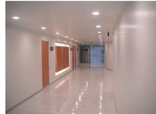
IMAGEN 092 Acabado final en muros interiores. P.B, 1°, 2°, 3er nivel.
