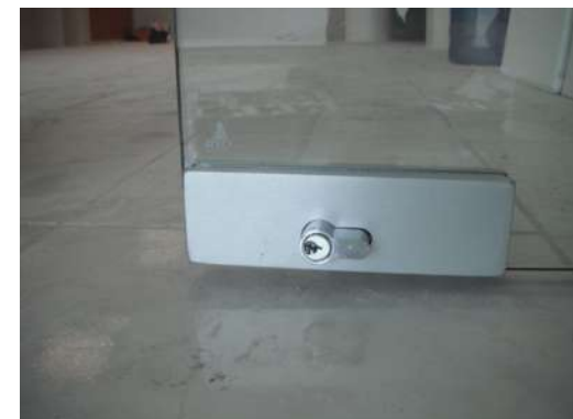
IMAGEN 181 Colocación de cerradura CR Laurence mod. AMR 205A en puerta de cristal. P.B, 1°, 2°, 3er nivel
