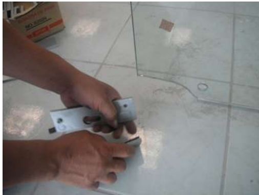
IMAGEN 176 Colocación de cerradura CR Laurence mod. AMR 205A en puerta de cristal. P.B, 1°, 2°, 3er nivel
