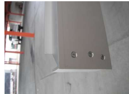
IMAGEN 162 Detalle de unión en perfil de aluminio tipo "L" o escuadra. P.B, 1°, 2°, 3er nivel
