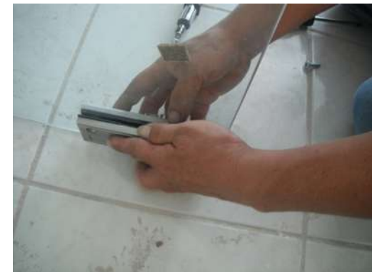
IMAGEN 180 Colocación de cerradura CR Laurence mod. AMR 205A en puerta de cristal. P.B, 1°, 2°, 3er nivel
