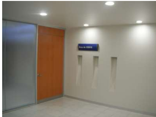
MAGEN 119 Puerta terminada colocada sobre cancel de aluminio. P.B, 1°, 2°, 3er nivel
