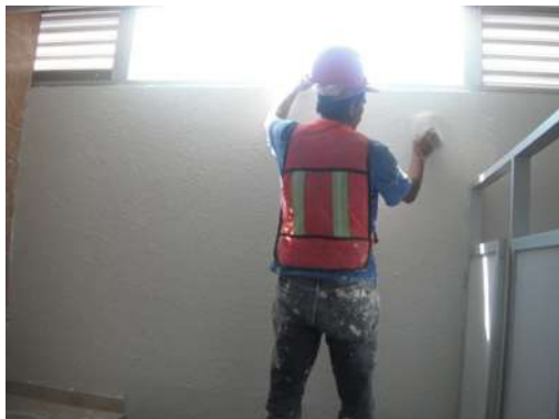
IMAGEN 084 Aplicación de pasta texturizada en muros interiores color blanco. Planta Baja.
