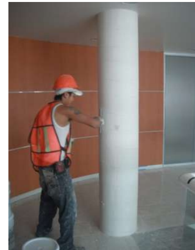
IMAGEN 058 APLICACIÓN DE PERFACINTA Y REDIMIX PARA DAR ACABADO FINO EN COLUMNAS SEGUNDO NIVEL
