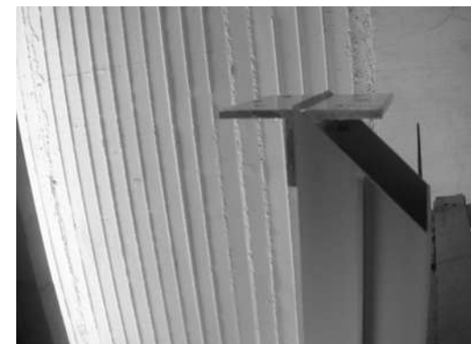
IMAGEN 163 Detalle de unión en perfil de aluminio tipo "T" o escuadra. P.B, 1°, 2°, 3er nivel
