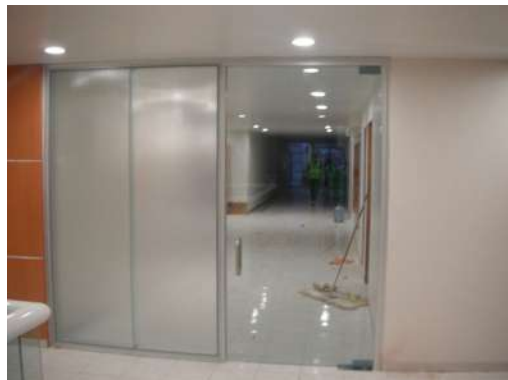
IMAGEN 171 Cancel K-28 terminado en bastidor, cristal y costillas así como el sellado con silicona. 3er nivel
