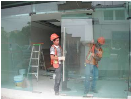
IMAGEN 183 Colocación de puerta de cristal. Planta Baja.
