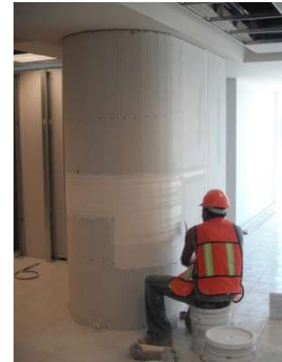
IMAGEN 044 PROCESO DE CALAFATEO DE JUNTAS CON PERFACINTA Y COMPUESTO REDIMIX ESQUINAS TRATADAS CON ESQUINERO METALICO O TIPO PERFA TRIM SEGUNDO NIVEL
