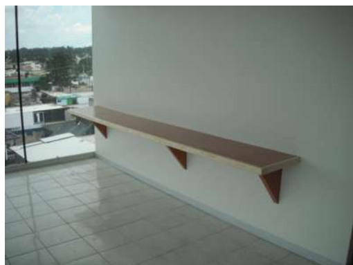
IMAGEN 153 Barras de trabajo terminados. Tercer nivel.
