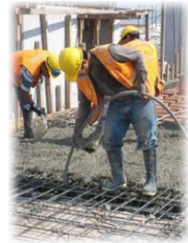
Imagen 36 Proceso de colado en losa maciza. http://www.civil.cicloides.com/losas/3.11/ Enero 2013
