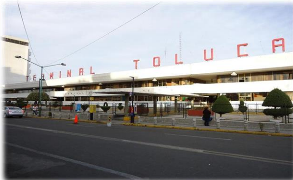
Acceso principal de la terminal de Toluca. Se observa que el espacio disponible es muy reducido para la circulación.
