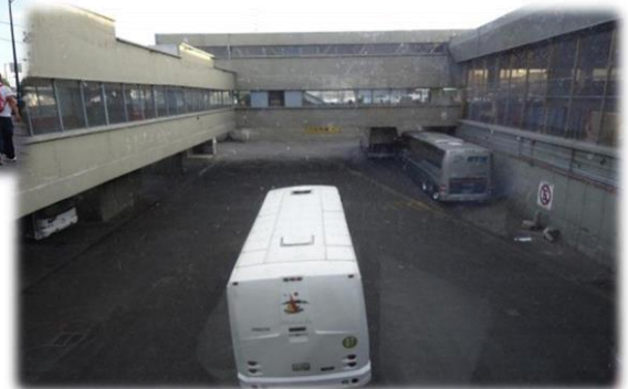
Vista del edificio, espacios reducidos
