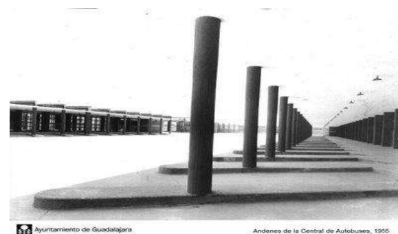
Andenes de la Central de Autobuses, 1955. Guadalajara
