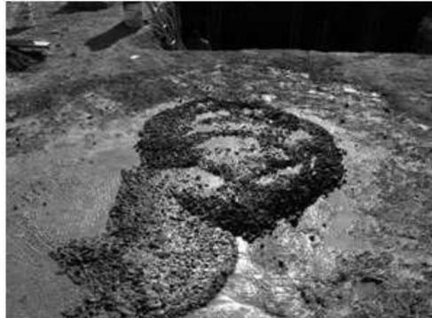
Imagen 54 Mezcla de cemento agua y agregados gruesos y finos.
