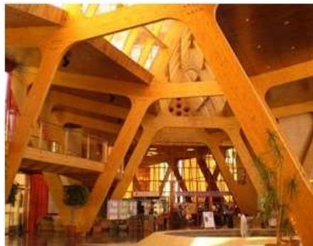
Imagen 57 estructura de madera laminada.
