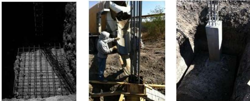
Imagen 52. El concreto premezclado es vaciado en moldes y reforzado con barras de acero.
