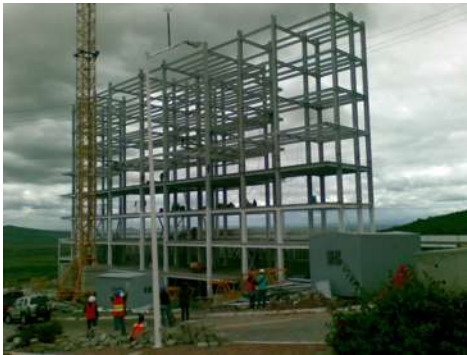
Imagen 87 Estructura de pórticos. 144
