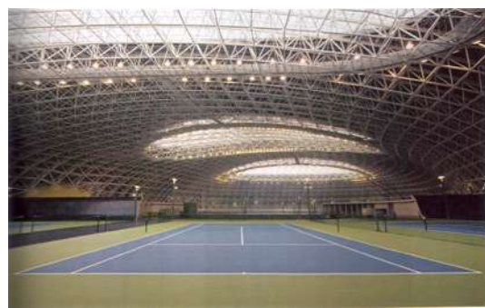
Imagen 84 Estructura de mallas espaciales. 141
