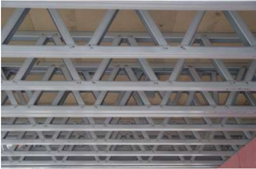
Imagen 79 Estructura de Cerchas Planas. 136
