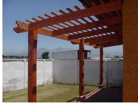
Imagen 86 Estructura de vigas de madera. 143
