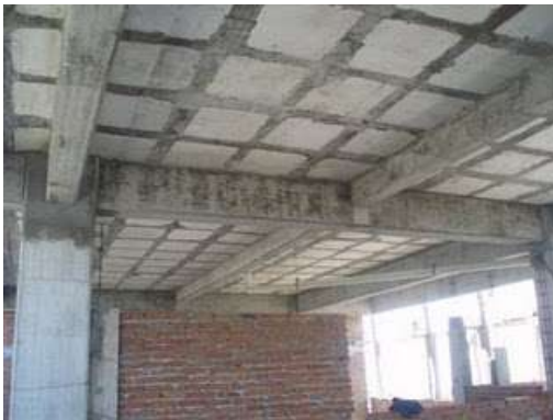
Imagen 89 Estructura de losas (losa nervada). 146
