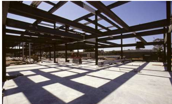
Imagen 88 Estructura de retícula de vigas. 145
