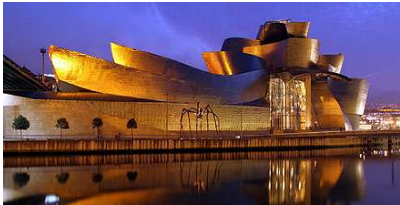
Imagen 94 Estructura de membranas. (Museo Guggenheim; Bilbao, España). 151
