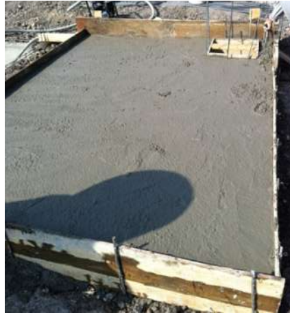
Imagen 91 Estructura de losas (losa uniforme). 148
