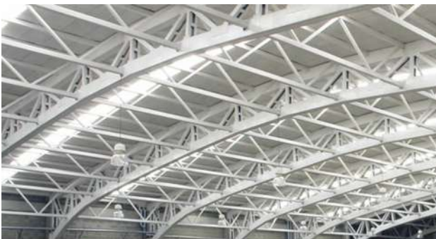
Imagen 83 Estructura de cerchas curvas. 140
