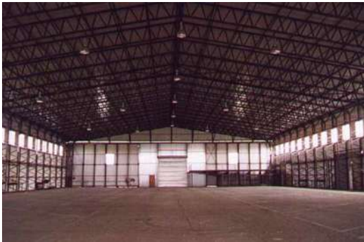
Imagen 81 Estructura de cerchas planas combinadas. 138 139
