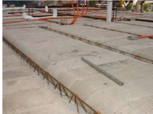
Imagen 90 Estructura de losas (la nervada). 147
