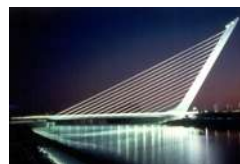
Imagen 69 Puente Alamillo; Valencia, España. 126
