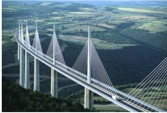
Imagen 70 Viaducto de Millau; Aveyron, Francia. 127
