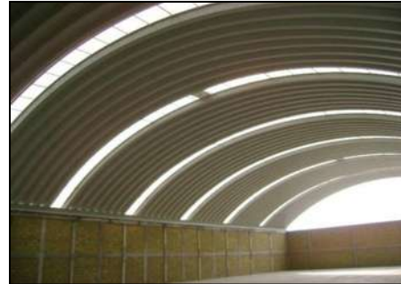
Imagen.-85.- La cubierta Cónica cubre grandes claros con pocos apoyos centrales o
