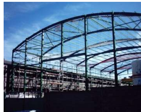
Imagen 86.-Propuesta de Estructuras Metálica para el
