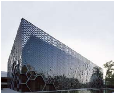
La malla irregular en panal de la fachada de la Galería OCT de Arte y Diseño, confiere un aire decididamente moderno a la estructura de la galería, que queda interrumpida por la elevación de una forma interior regular.
