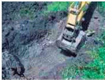
Excavación del pozo a cielo abierto No. 2
