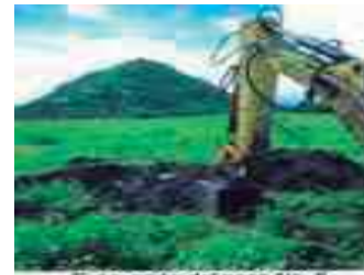
Excavación del pozo No. 5
