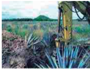
Excavación del pozo a cielo abierto No. 1
