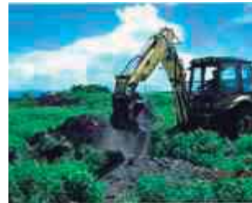
Excavación del pozo No. 3
