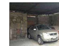
Vista interior tapiado de ventana
