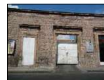
Vista Fachada Sur
