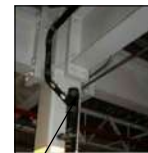
Detalle de instalación sanitaria bajo la losa, S.A.P.
