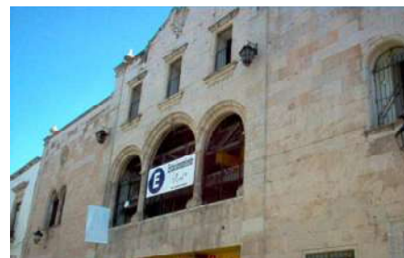
Imagen 02. Levantamiento fotográfico. Estacionamiento Calle García Obeso.
