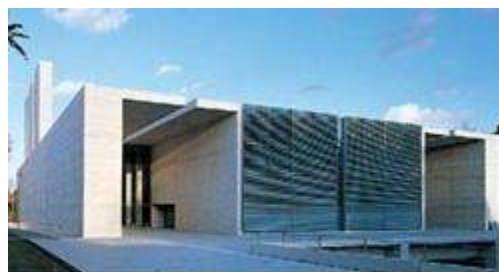
ILUSTRACIÓN 7: FACHADA PRINCIPAL DEL CREMATÓRIO
