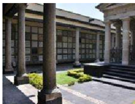
ILUSTRACIÓN 13: CAMINO DE LOS NICHOS A BASE DE CUBIERTA DE CONCRETO Y COLUMNAS http://es.wikipedia.org/wiki/pante%C3%B3n_de_San_Fernando Fecha de consulta: 23 de Agosto del 2012
