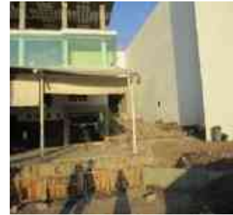
Imagen 97. Pasillo en construcción para acceder al auditorio. Fuente: GuiCast
