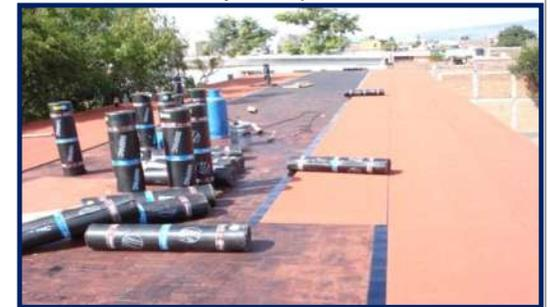
c) Impermeabilizante prefabricado, aplicado con flama de gas butano.
