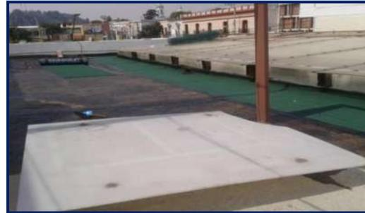
c) Aplicación de impermeabilizante prefabricado en puntos críticos.
