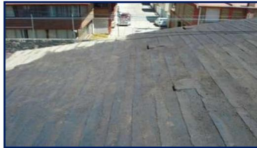
c) Nivelación de losa con mezcla asfáltica.
