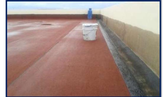
c) Impermeabilizante prefabricado, aplicado con flama de gas butano.
