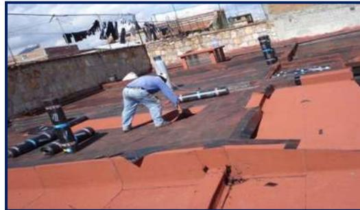
c) Impermeabilizante prefabricado aplicado en losa, y cubriendo puntos críticos.
