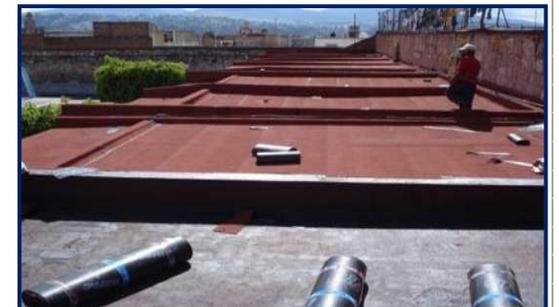
c) Aplicación de impermeabilizante prefabricado, con flama de gas butano.
