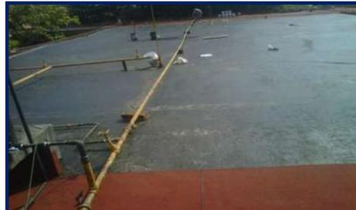
c) Aplicación de impermeabilizante prefabricado, alineado y traslapado a cada 10 cm.
