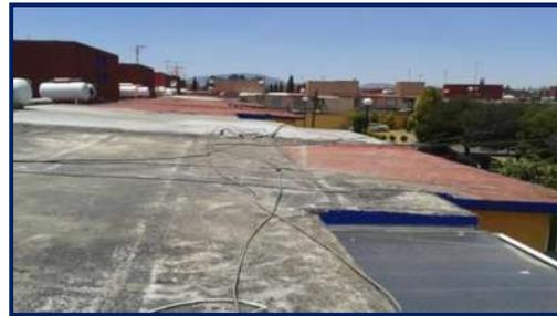
c) Aplicación de impermeabilizante prefabricado, alineado e iniciando desde la parte mas baja y traslapado a cada 10 cm.
