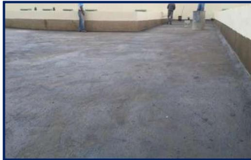
c) Aplicación de impermeabilizante prefabricado, alineado y traslapado a cada 10 cm.
