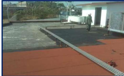
c) Aplicación de impermeabilizante prefabricado, alineado y traslapado a cada 10 cm.
