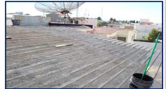
c) Aplicación de impermeabilizante prefabricado
