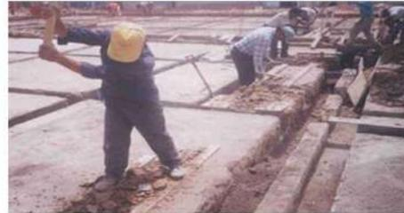
c) Desplante de muros con geoblock hueco, refuerzo vertical, escalerilla de refuerzo y relleno de mortero.
