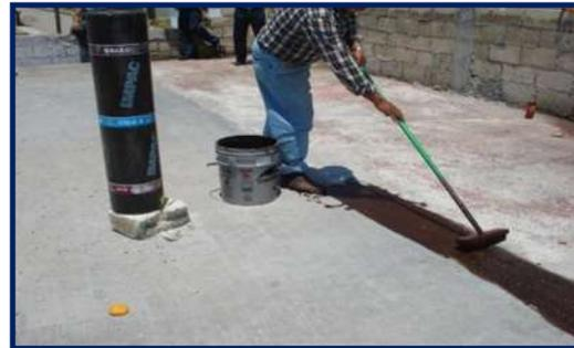
c) Aplicación de impermeabilizante prefabricado, reforzado en punto crítico.
