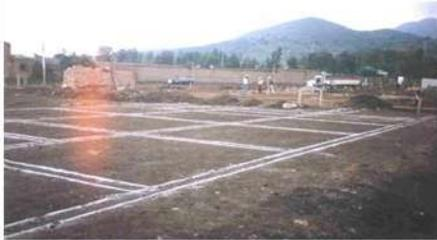
b) Compactación de suelo para recibir losa de cimentación y excavación para contratraves.
