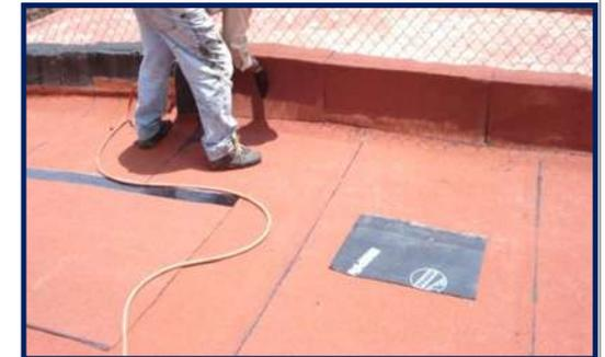
c) Impermeabilizante prefabricado, aplicado con flama de gas butano.
