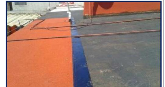
c) Aplicación de impermeabilizante prefabricado con flama de gas butano.
