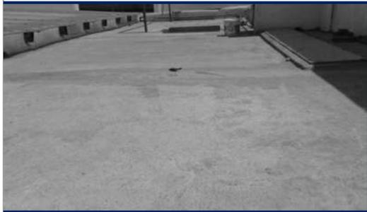
b) Superficie con sello asfáltico base agua e impermeabilizante prefabricado alineado.
