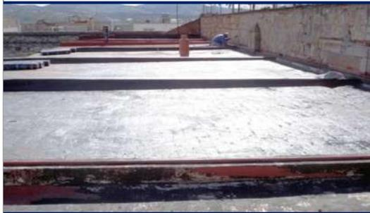
b) Superficie con sello asfáltico base agua e impermeabilizante prefabricado alineado, realizando traslapes a cada 10 cm.
