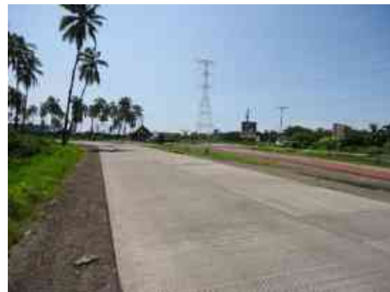
Ilustración 13. Vista F4: Vista hacia el sureste en boulevard costero, se puede apreciar la glorieta y enramadas. Fotografía de AHMZ
