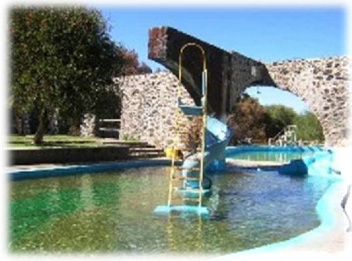
IMAGEN 31: Fotografía de una sección del acueducto Mariano de la Piedra, en la alberca del balneario ejidal los arcos en Puruándiro Mich. Fuente: fotografía tomada por ARRT, marzo 2012.
