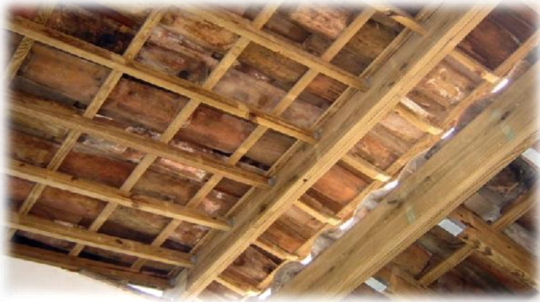
IMAGEN 61: Fotografía de una cubierta con largueros, alfajillas y tejas de barro. Fuente: http://www.mecma.com.mx/construcciones/linea-de-cubiertas
