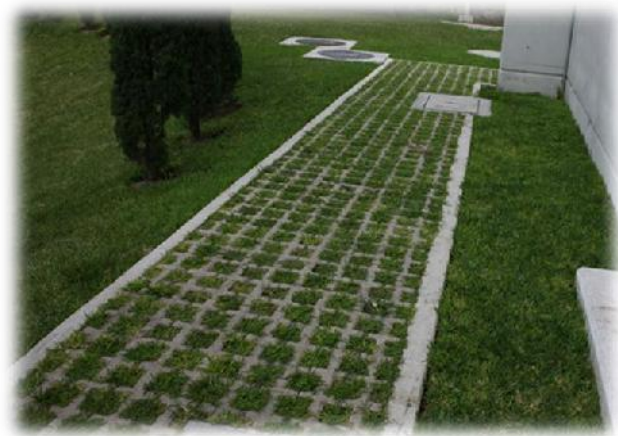
IMAGEN 60: Fotografía de una sección de la colocación de adopasto en un jardín. Fuente: http://www.napresa.com.mx
