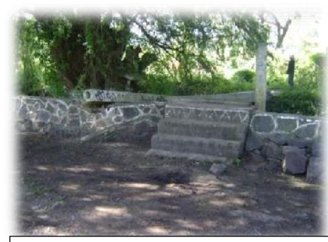
Fotografía 3.- puente. Fuente: fotografías tomadas por ARRT, diciembre 2011.
