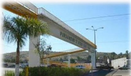
Uno de los puentes que cruzan el boulevard en la ciudad de Puruándiro. Fotografía tomada por ARRT.
