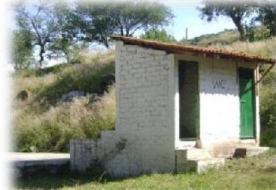
Fotografía 5.- baños. Fuente: fotografías tomadas por ARRT, diciembre 2011.
