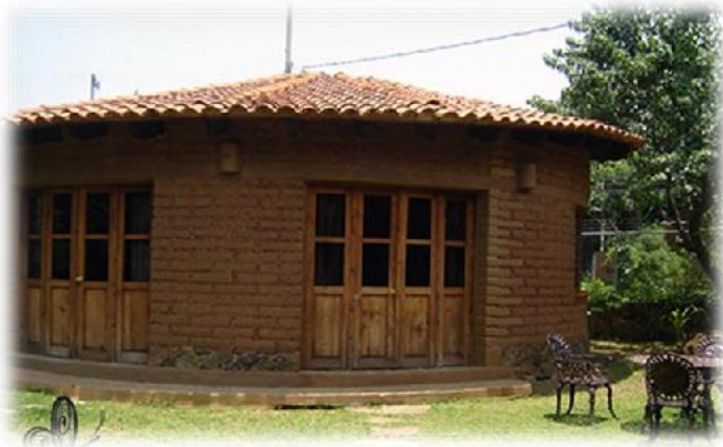
IMAGEN 62: en la fotografía se muestra un muro de adobe. Fuente: http://www.flickr.com/photos/takeatour/3821895176/
