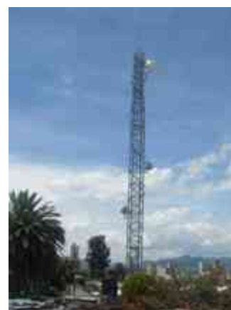
Imagen 41. Antenas de internet así como telefonías.
