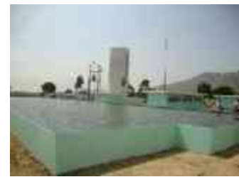
Imagen 35. Tanques elevados de agua.
