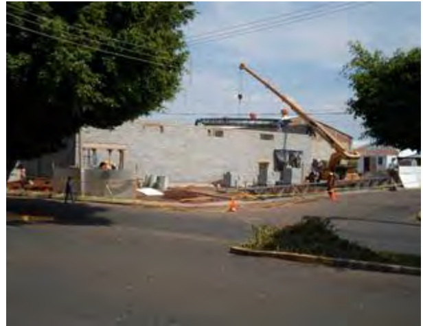
Imagen 43. Equipamiento de comercialización y abasto. Construcción de una bodega con material prefabricado. Fotografía tomada por: Arianna C. Navarrete A. el 20 de octubre de 2012.
