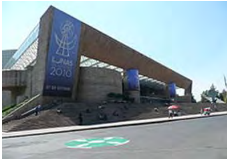
Imagen 10. Auditorio Nacional (México). Remodelación en 1988 junto con el arquitecto Abraham Zabludovsky, se realizó una ampliación del recinto y mejoras en instalaciones, se revistió en su fachada con concreto martelinado, sello de las obras de ambos arquitectos. Obtenida el 05 de febrero de 2013 de http://es.wikipedia.org/wiki/Auditorio_Nacional
