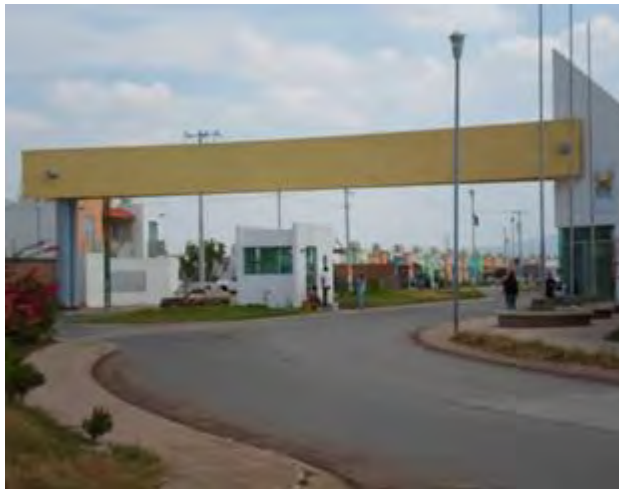
Imagen 45. Equipamiento Urbano. Acceso principal al Fraccionamiento Altamira Residencial. El terreno se ubica al costado izquierdo del acceso. Fotografía tomada por: Arianna C. Navarrete A. el 20 de octubre de 2012.
