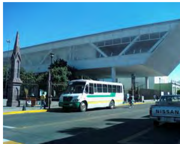
Imagen 23. Centro Regional de las Artes. Fachada principal sobre la Av. 5 de Mayo. Fotografía tomada por: Arianna C. Navarrete Arredondo el 24 de marzo de 2012.
