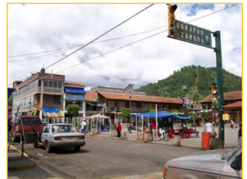
Imagen No. 75C – Fachada del portal Galeana. TLO
