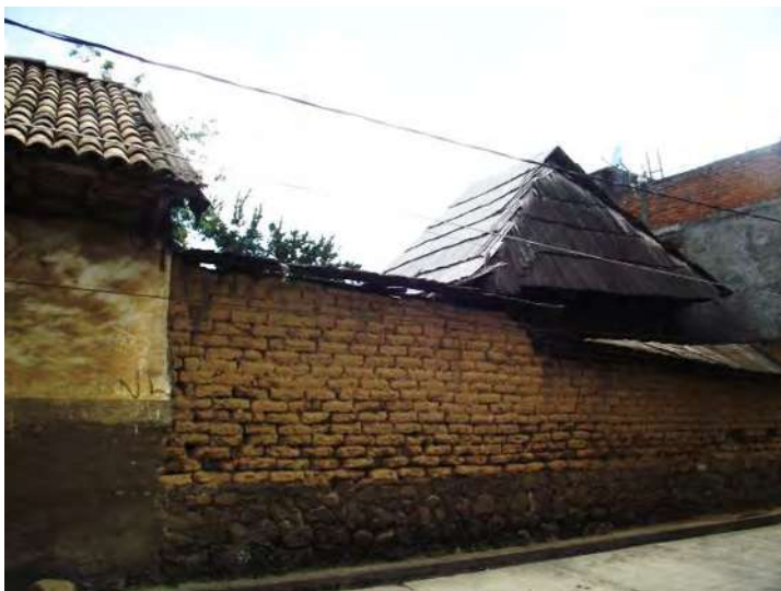
Imagen No. 138 – Muros de piedra y adobe. TLO
