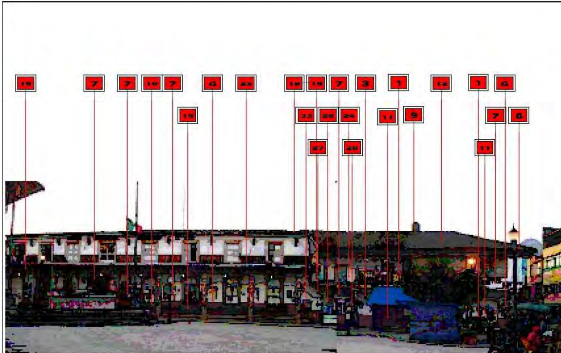
PORTAL HIDALGO (Estado actual)
