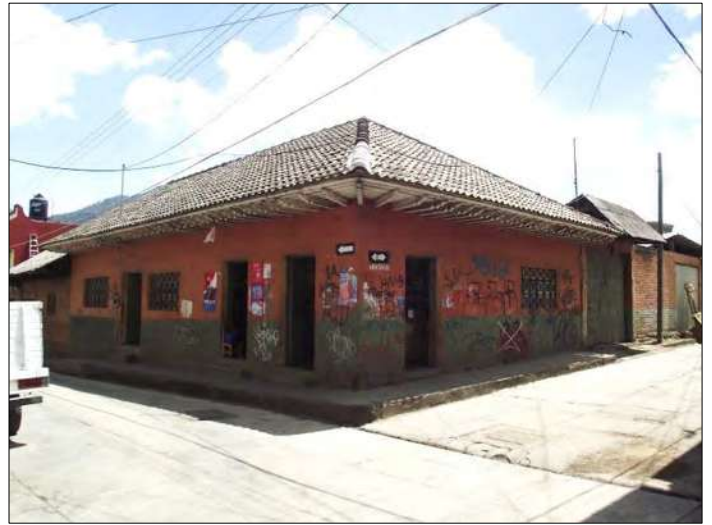
Imagen No. 123 – Casa con cuatro puertas, ventanas y zaguán. TLO
