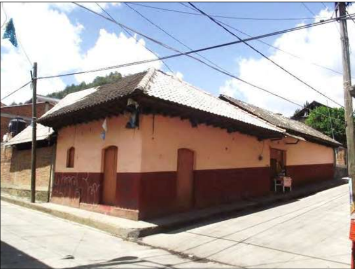
Imagen No. 122 – Casa con dos puertas, un portón y una ventana. TLO
