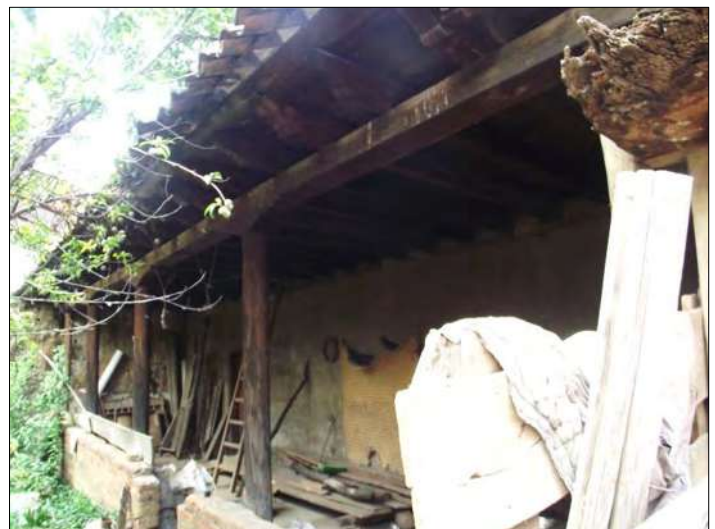
Imagen No. 128 – Portal interior. TLO
