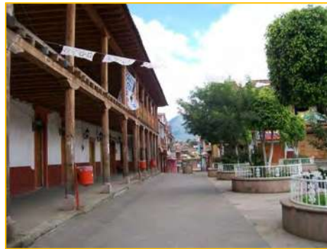
Imagen No. 74A – Portal Galeana. TLO
