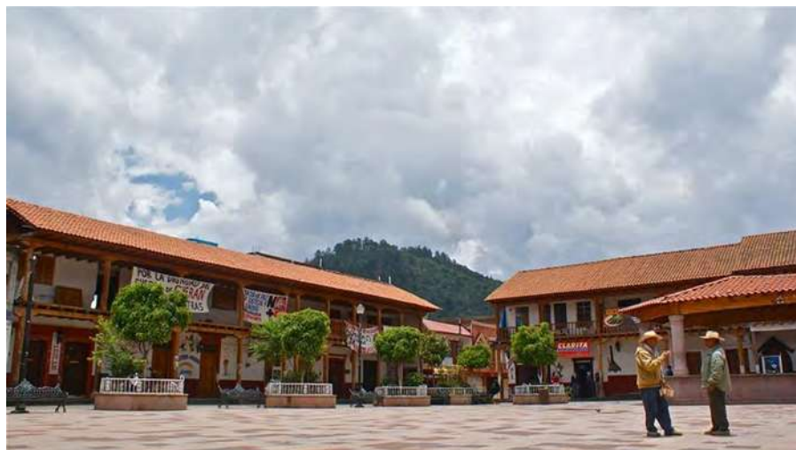
Imagen No. 102 – Fachada del Portal Galeana y Portal Juárez. www.purepecha.mx
