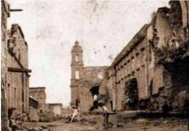
Fig. 20 Fotografía de 1865 en donde se realizaban trabajos de reconstrucción en calles y fachadas.
