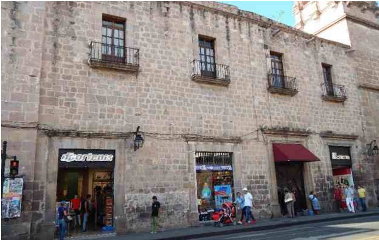
Fig. 41 Fachada de edificio comercial en Madero oriente no.293, las puertas en planta baja y dos barandales en planta alta fueron reemplazados.
