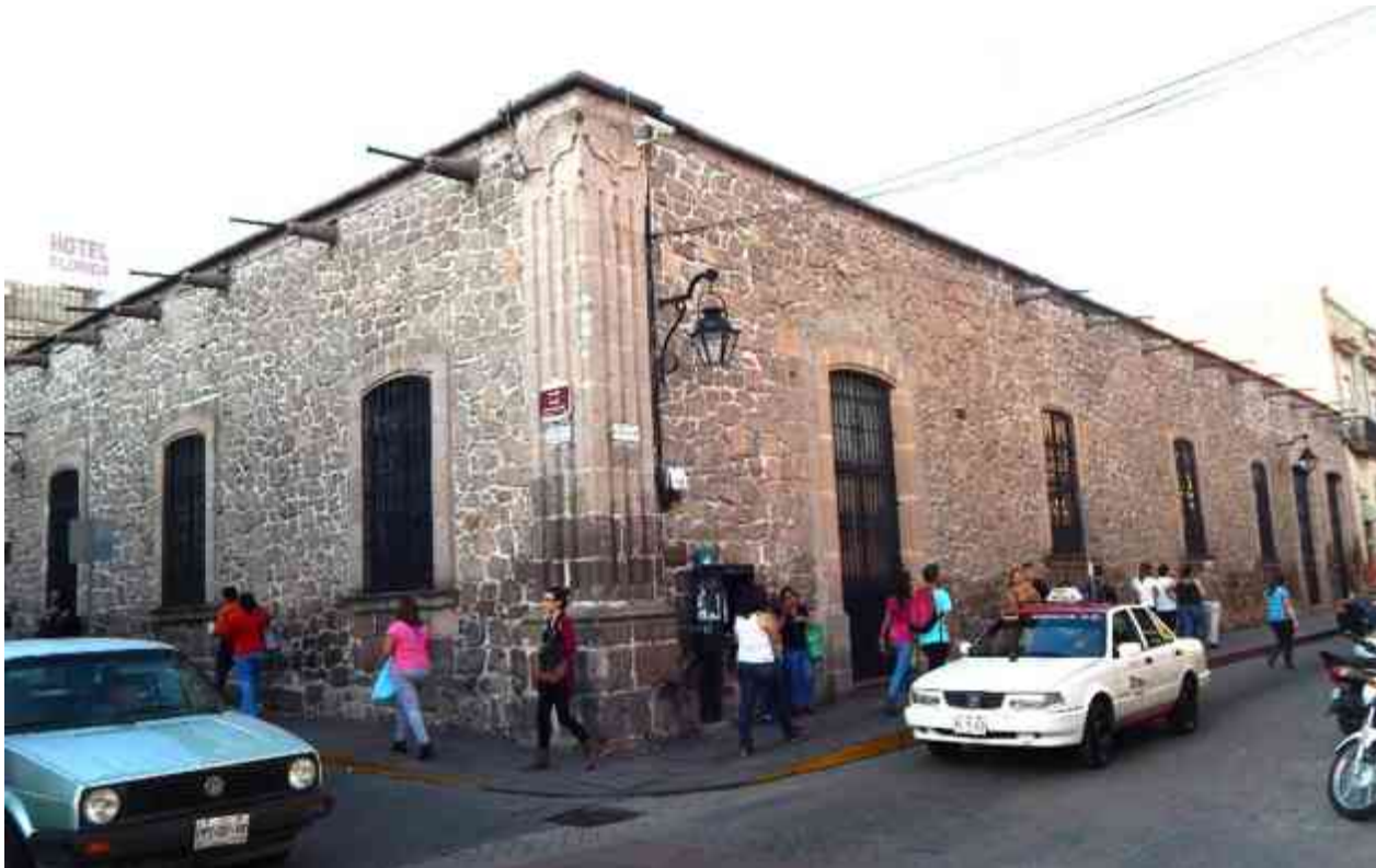
Fig. 37 Edificio cuya parte de la fachada sur se demolió para crear un nuevo vano de acceso. Fotografía de la autora.
