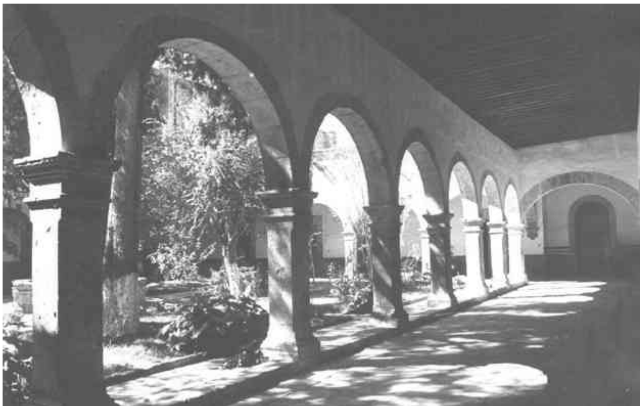
Fig. 40 Fotografía del Conservatorio Las Rosas donde se observa un vano al final del pasillo.
