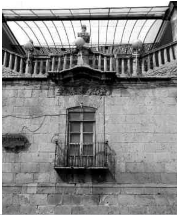
Fig. 33 Cubierta de estructura metálica en Madero poniente 388. Fotografía de la autora.
