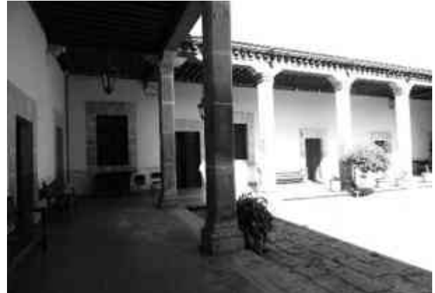
Fig. 11 Misma vista del Conservatorio las Rosas en 2014, ahora los muros han sido revestidos. Fotografía de la autora.
