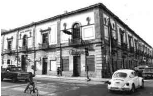
Fig. 02 Intersección de las principales avenidas: Madero y Morelos donde se aprecia el entonces Hotel Oseguera, 1981.
