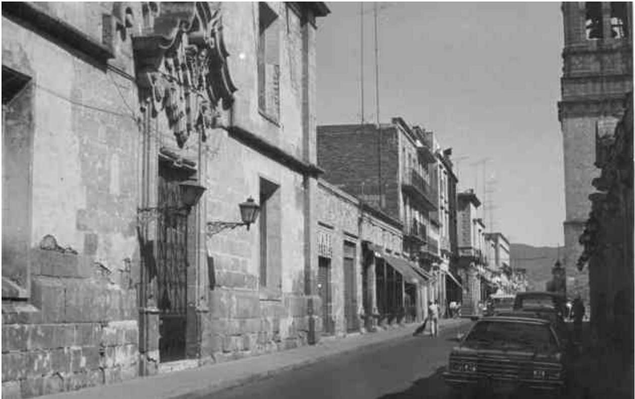
Fig. 36 Fachada de la entonces Casa Ex-alhóndiga donde se observa el deterioro en revestimientos. Fotografía de Esperanza Ramírez.
