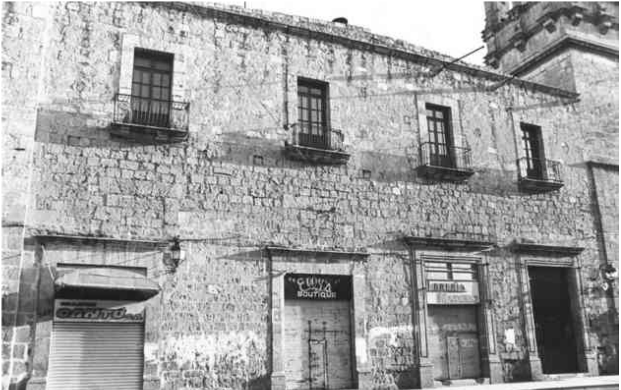
Fig. 42 Antigua fachada de edificio en Madero oriente no.293. Fotografía de Esperanza Ramírez.
