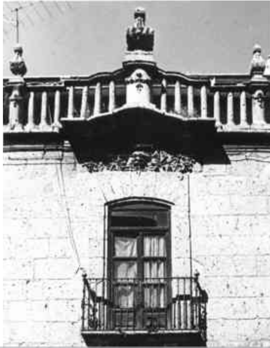
Fig. 34 Detalle de fachada de edificio en Madero poniente no.388 Fotografía de Esperanza Ramírez.
