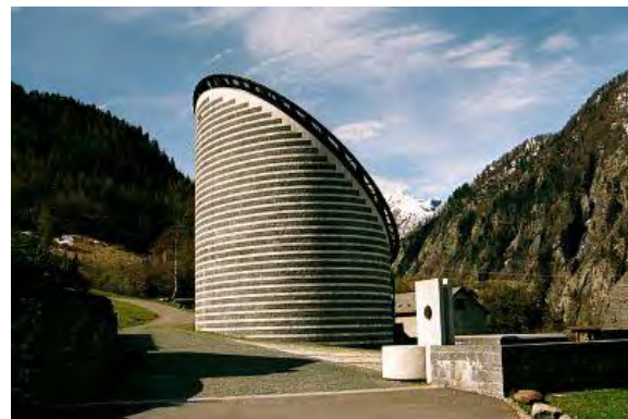
Imagen 27, Vista exterior del edificio
