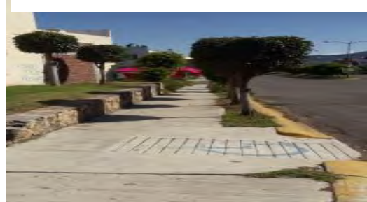
Imagen 7, Banquetas y Rampas, FMC, IV
