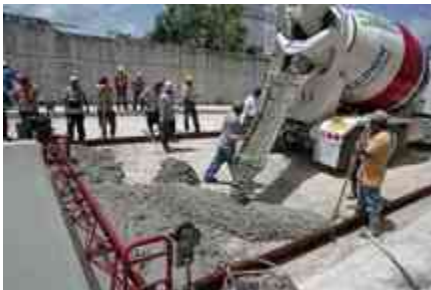
Imagen 93.- Vaciado de concreto premezclado.
