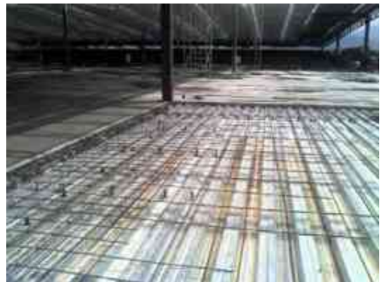
Imagen 103.- Losacero preparada para colar.
