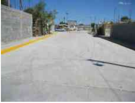
Imagen 81.- Calle de concreto hidráulico.
