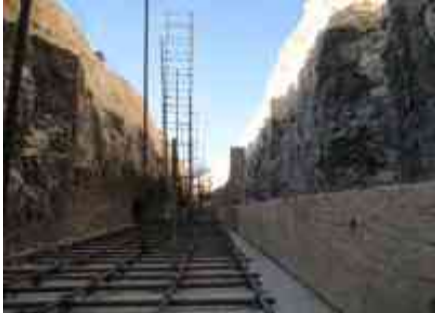
Imagen 102.- Armado de una zapata corrida.
