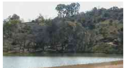
Imagen 51.- Presa del Bañito.
