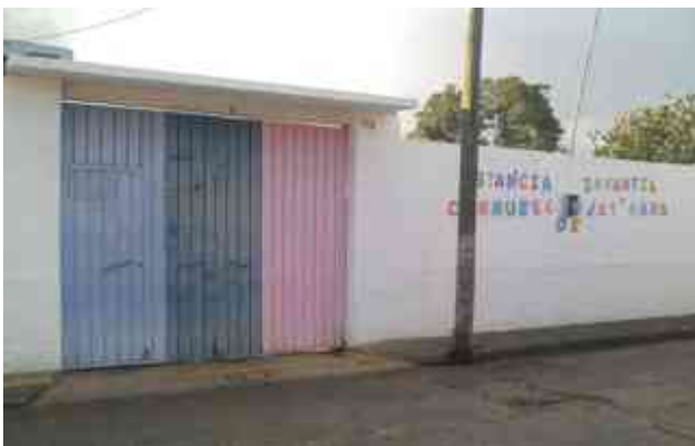
Imagen 38. Fachada y Portón de Acceso.
