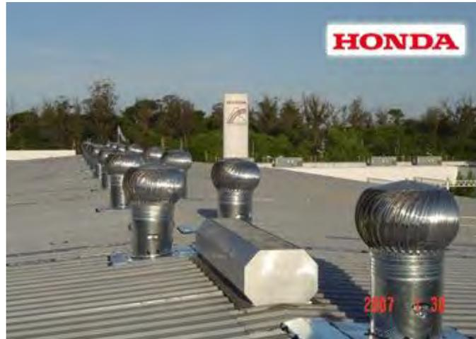
Imagen 48 de extractores colocados sobre la cubierta de una nave industrial<sup>19</sup>
