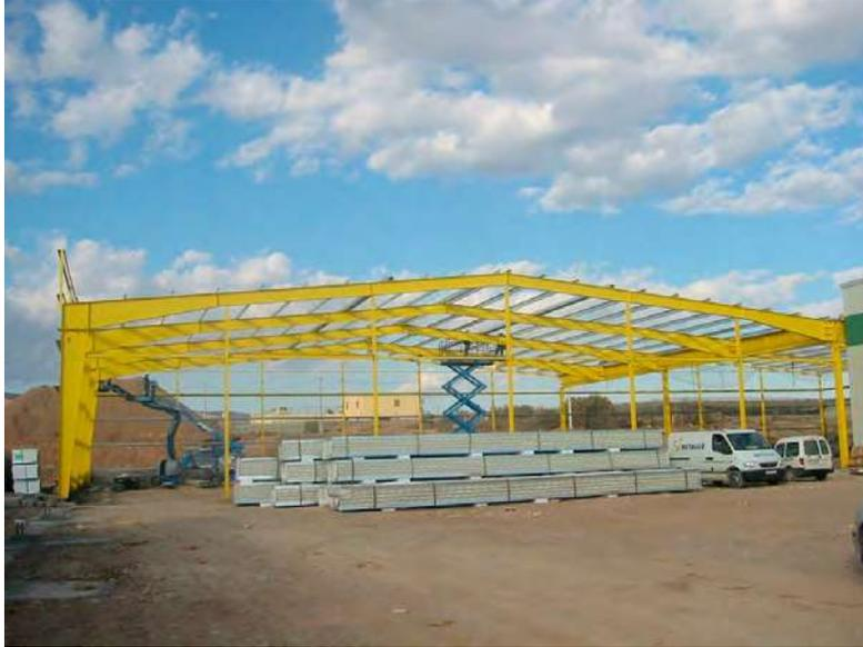
Imagen 34 Esqueleto de una nave industrial de estructura metálica.<sup>2</sup>
