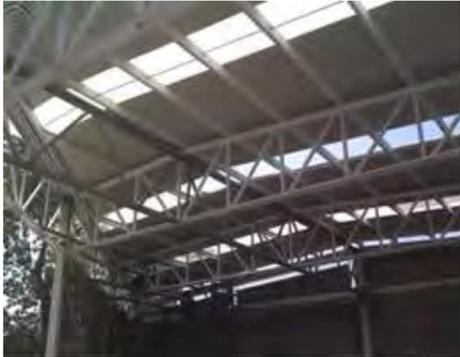
Imagen 39 de cubierta con lamina translucida<sup>8</sup>
