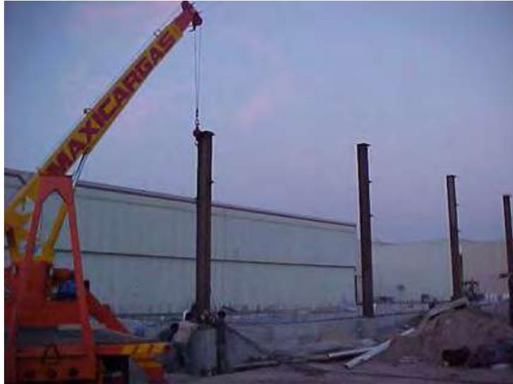
Imagen 35 Fotografía del proceso de colocación de columnas metálicas tipo IR<sup>4</sup>
