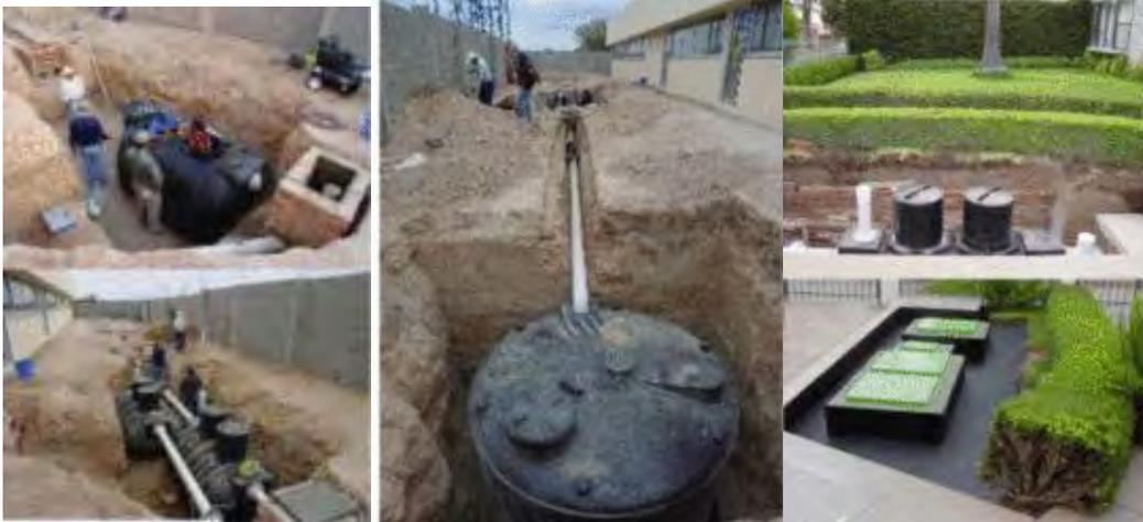
Imagen 60 Instalación del sistema Biodeg
